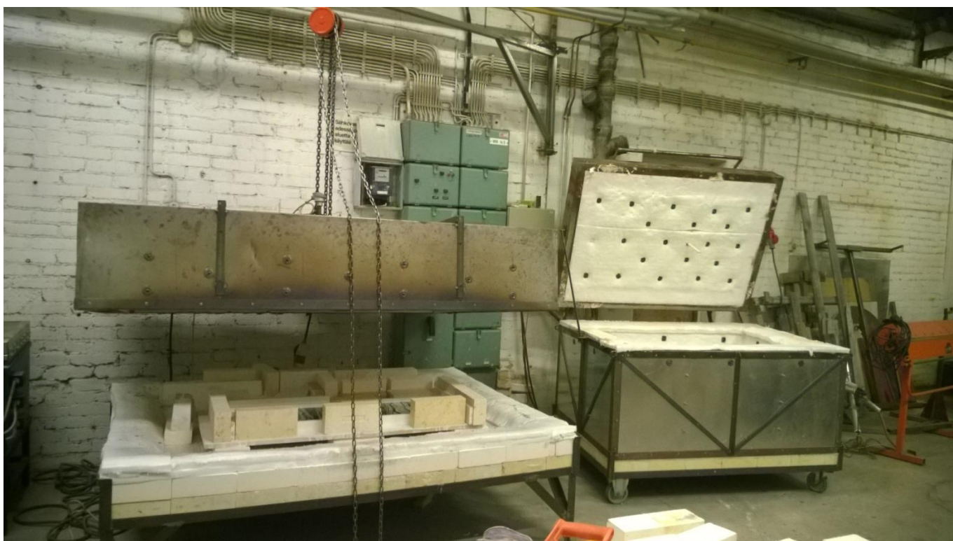
Kuva 3 Vasemmalla Uuni 1 ja oikealla Uuni 4
