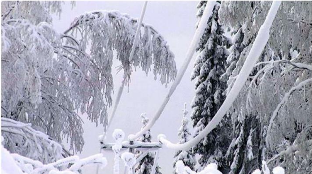
Kuva 5. Tykkylumen painama koivu keskijännitejohtimella (Yle Etelä-Savo 2012)
