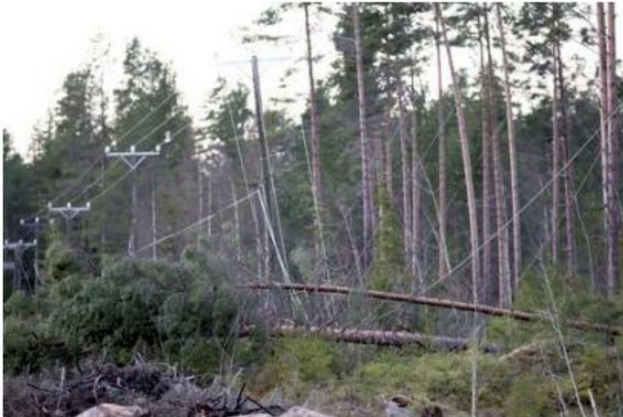
Kuva 3. Myrskytuhoja keskijänniteavojohdolla (Uusi-Rasi 2012, 12)
