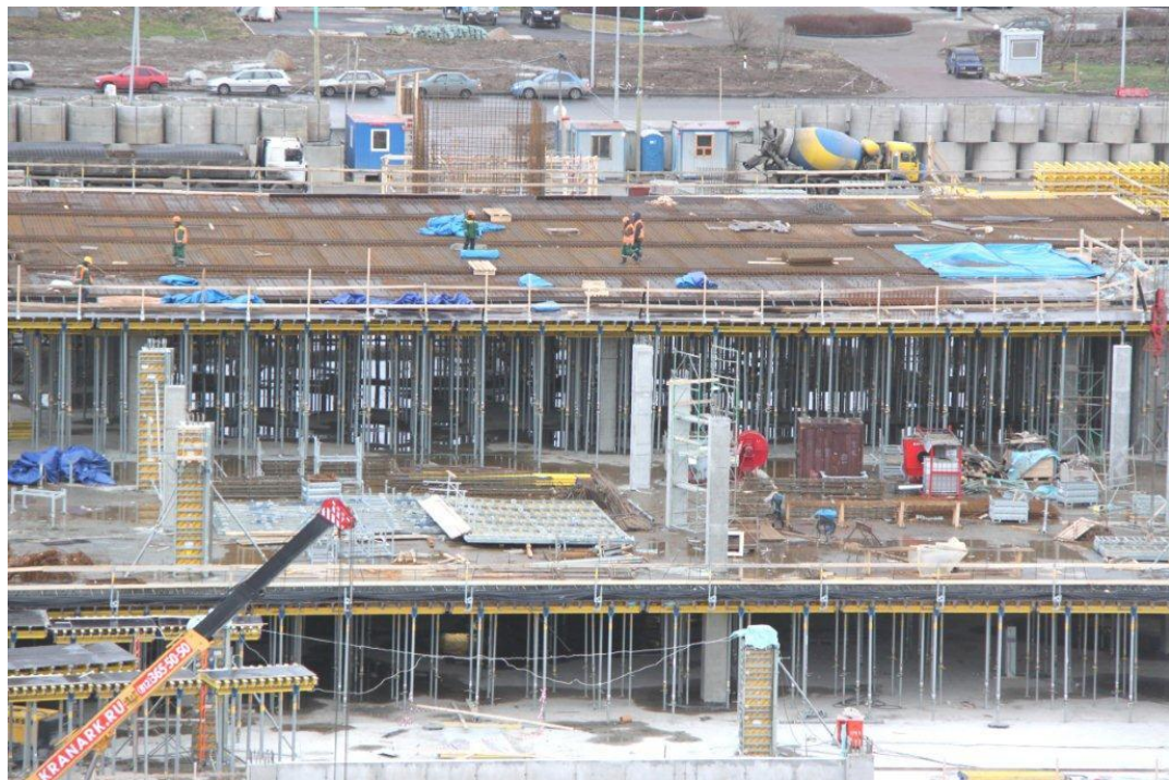
Kuva 10. Runkotyön eteneminen valulohkoittain.
