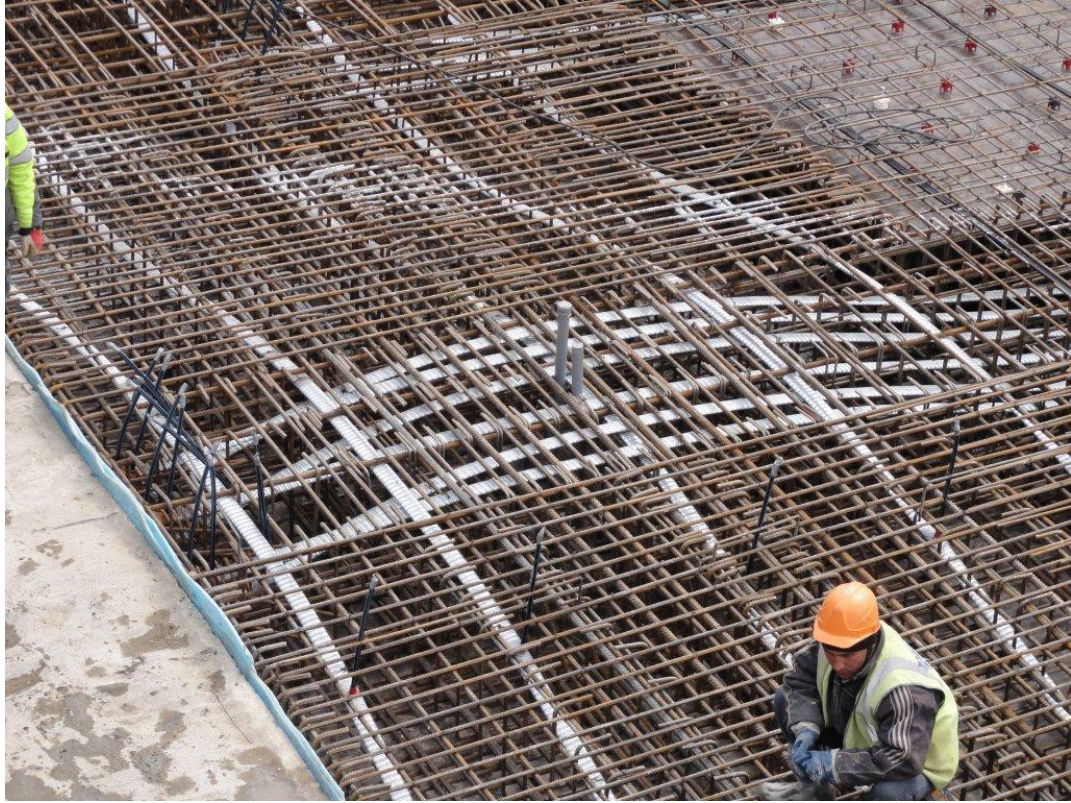
Kuva 2. Laatan ja palkin jännepunoksia.
