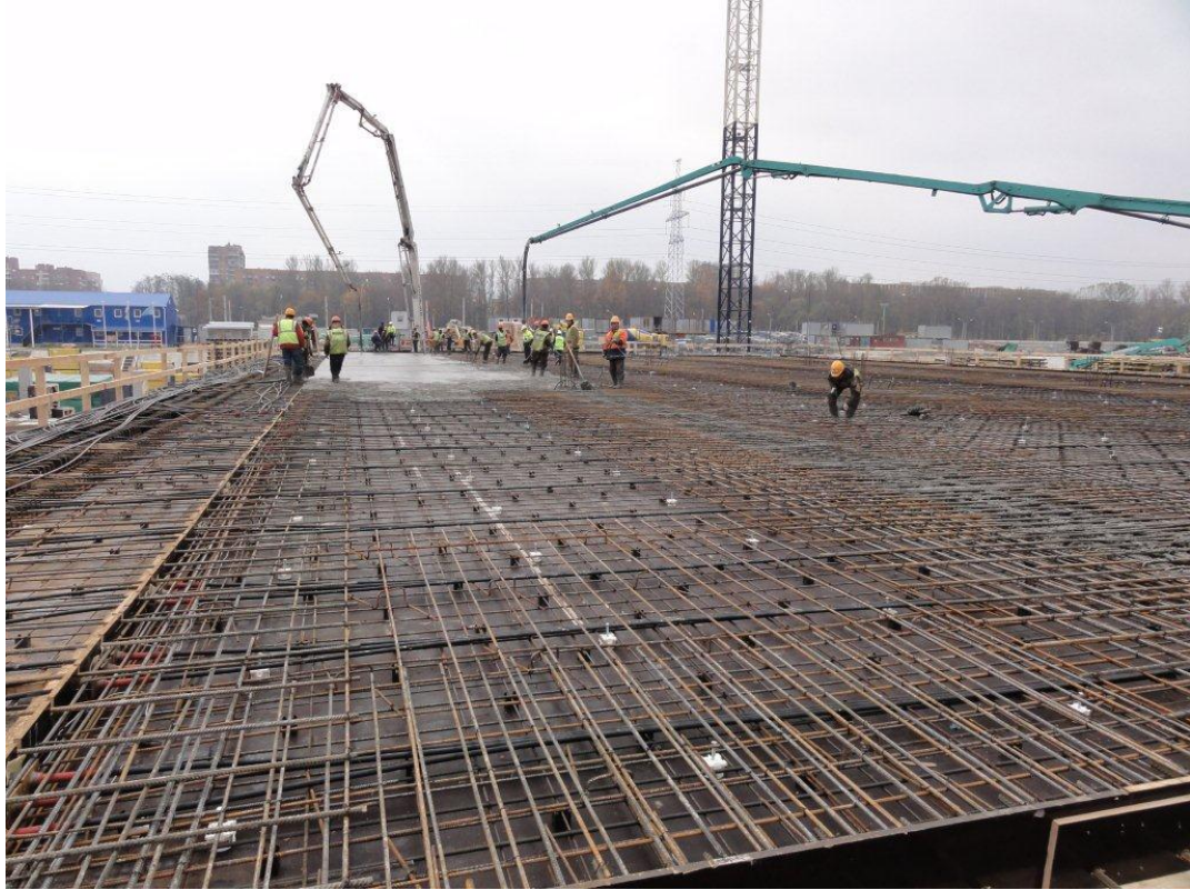
Kuva 8. Laatan valu käynnissä kahdella betonipumpulla.
