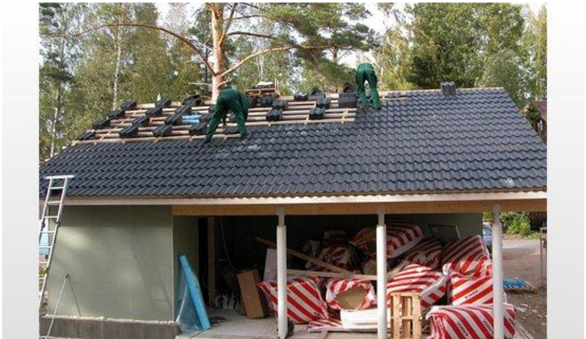
Kuva 4. Vesikaton teko kesäolosuhteissa.(Rakentaja.fi)
