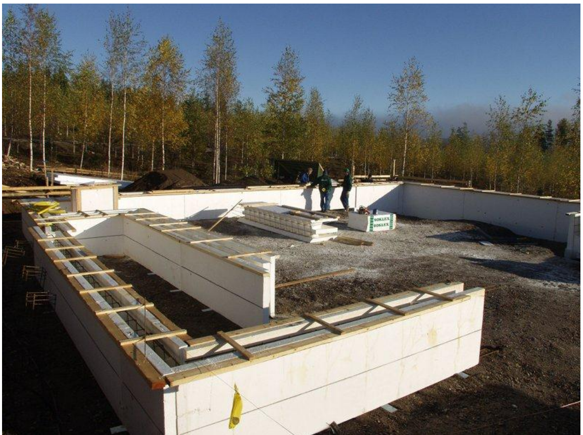
Kuva 1. Soklex perustusvalumuotti. (Soklex.fi)
