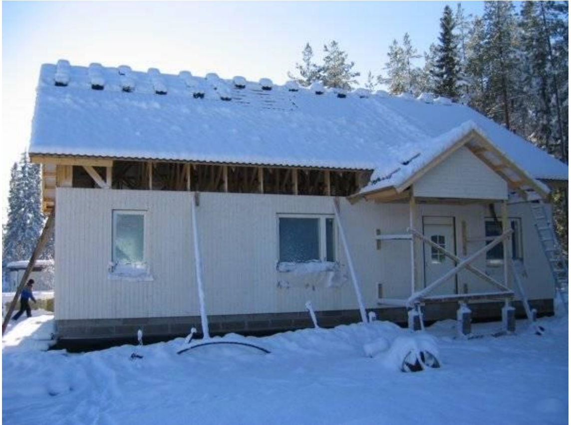
Kuva 3. Vesikaton teko on haastavaa talviolosuhteissa.(Rakentaja.fi)
