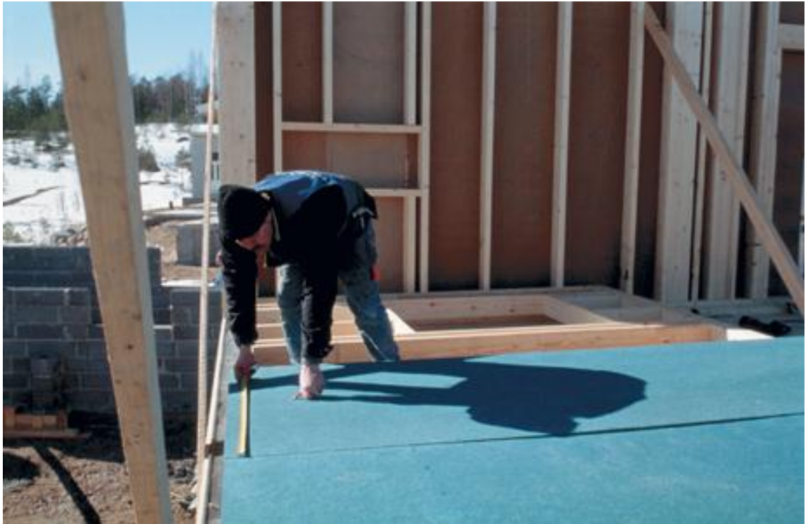
Kuva 2. Platform-rakentamista. (Rakentaja.fi)
