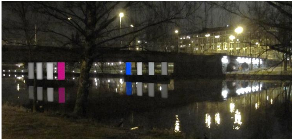
Kuva 16. Viipurintien sillan pylväiden valaisu.
