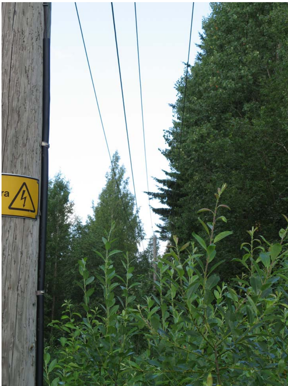
Kuva 7.1. Leventämisen tarpeessa oleva johtokatu.
