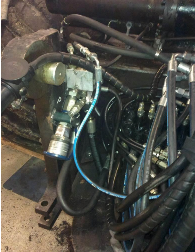
Kuvio 39. 29.11.2013 asennettiin painelinjan pikaliitin (Itäkylä 2013).
