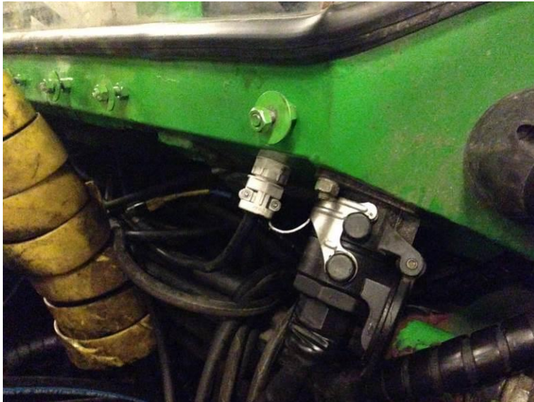
Kuvio 23. 16.3.2013 asennettiin moton sähköpistoke (Itäkylä 2013).
