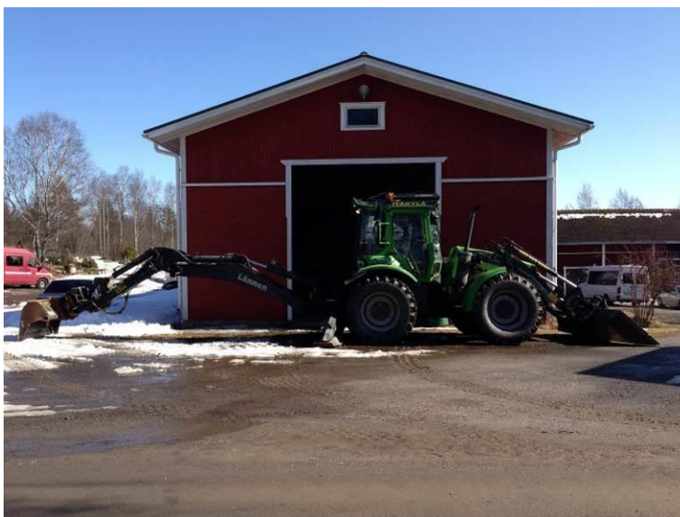
Kuvio 29 5.4.2013 asennettiin kaivupuomisto (Itäkylä 2013).
