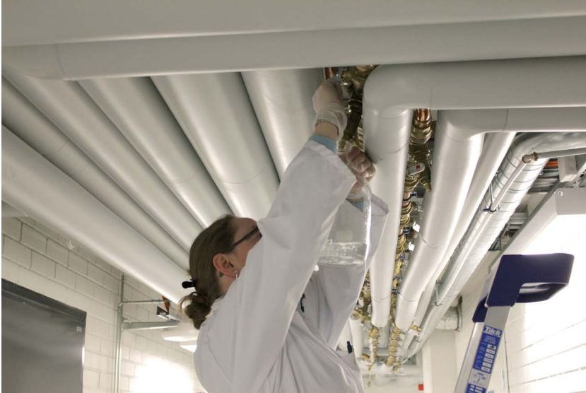
Kuva 3. Näytteenotto Sytyttimen tutkimusverkostosta.
