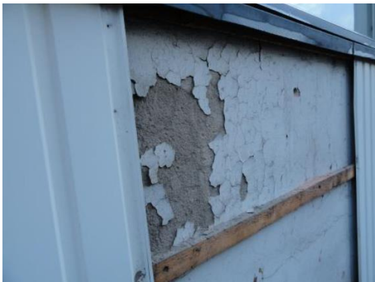
Kuva 13. Julkisivupinnoite verhoilun alla (Kuntotutkimusseloste, 2011, 8)
