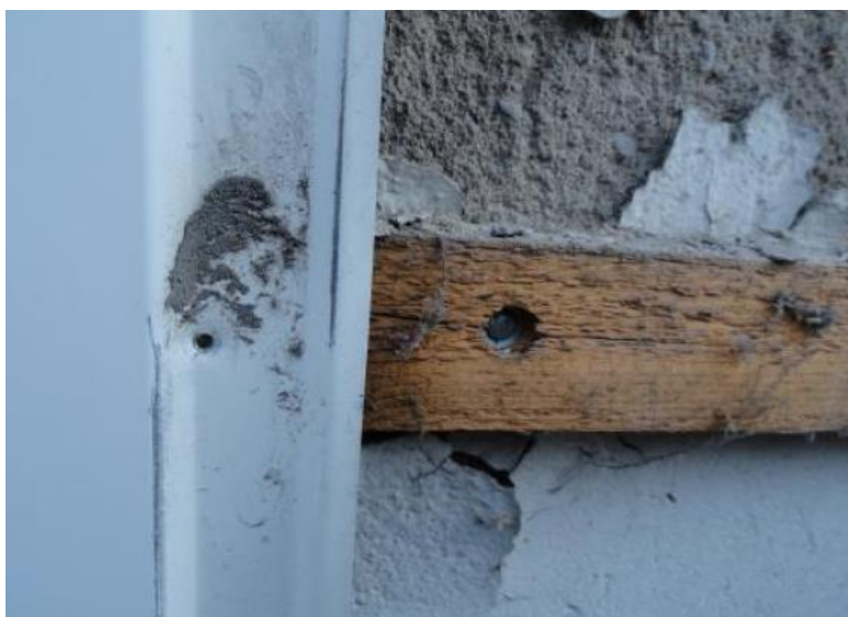
Kuva 10. Julkisivuverhouksen koolaus on naulattuna tiilirunkoon (Kuntotutkimusseloste, 2011, 8)
