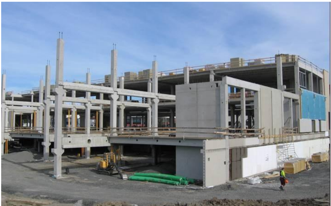
Kuva 1. Betonielementtirunkoinen talo rakennusvaiheessa. [2]
