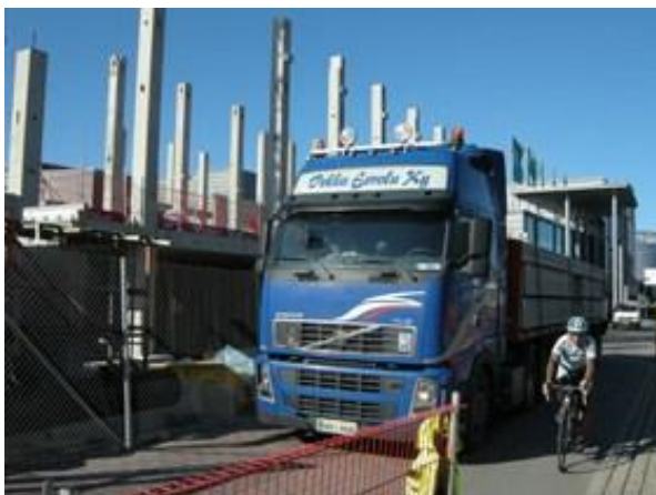
Kuva 6. Kuorma-auto tuomassa elementtejä rakennustyömaalle. [2]
