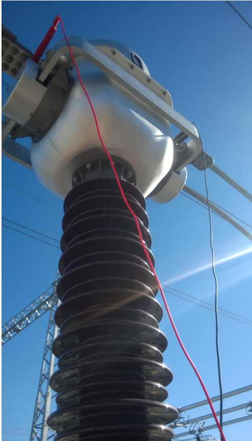
Kuva 15. Virtamuuntajan testaus (Närvänen 2014.)
