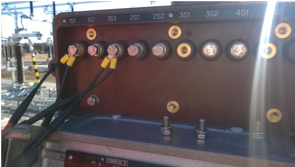
Kuva 16. Virtamuuntajan testaus (Närvänen 2014.)
