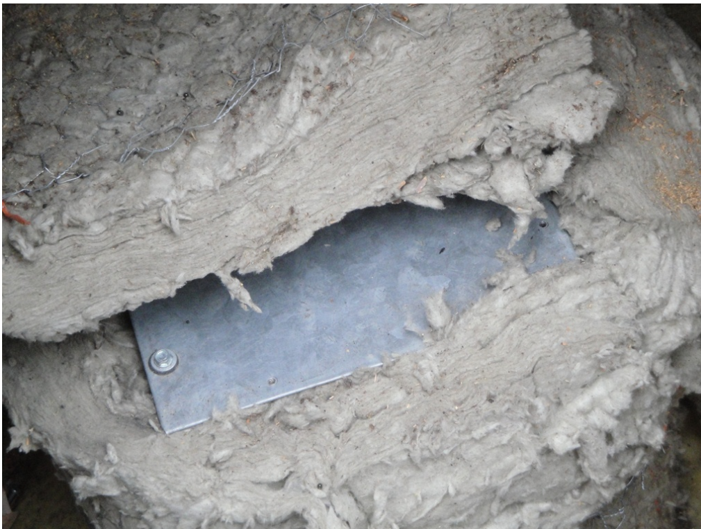
KUVA 11. Yläpohjassa iv-kanavan huoltoluukun eristys poissa paikaltaan
