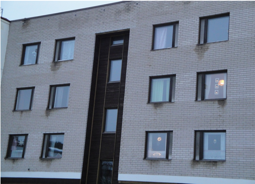
KUVA 14. Ikkunan vesipelleiltä ja räystääspelleiltä vuotaa/valuu vettä tiiliverhoksen päälle
