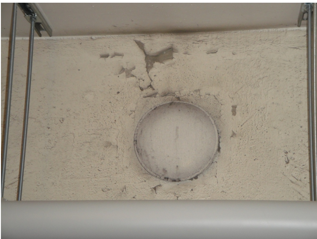
KUVA 28. Taloyhtiön pyykkituvan seinän maalipinta
