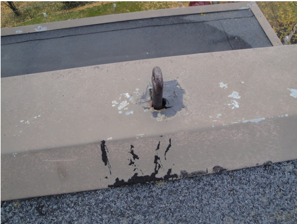
KUVA 8. Kattopollarin avoin / tiivistämätön läpivienti räystäspellin läpi
