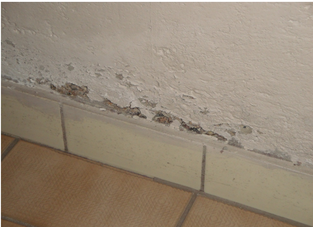
KUVA 6. Pyykinhuivaustilassa perusmuuri läpäisee kosteutta huonetilaan
