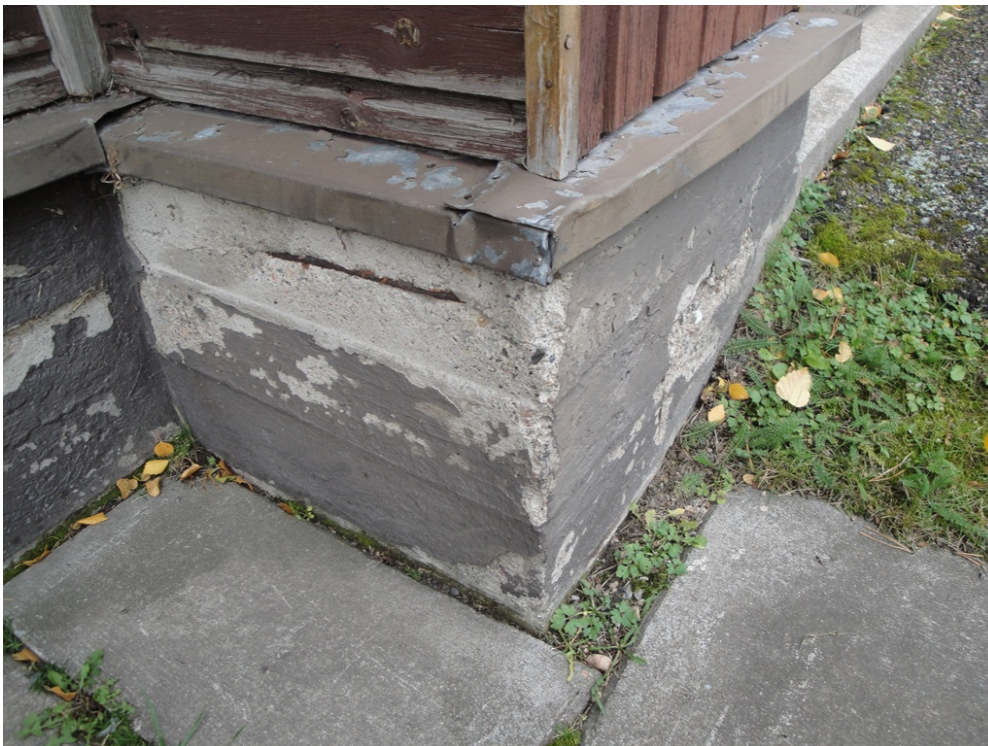
KUVA 3. Perusmuurin ja vesipeltien vaurioita
