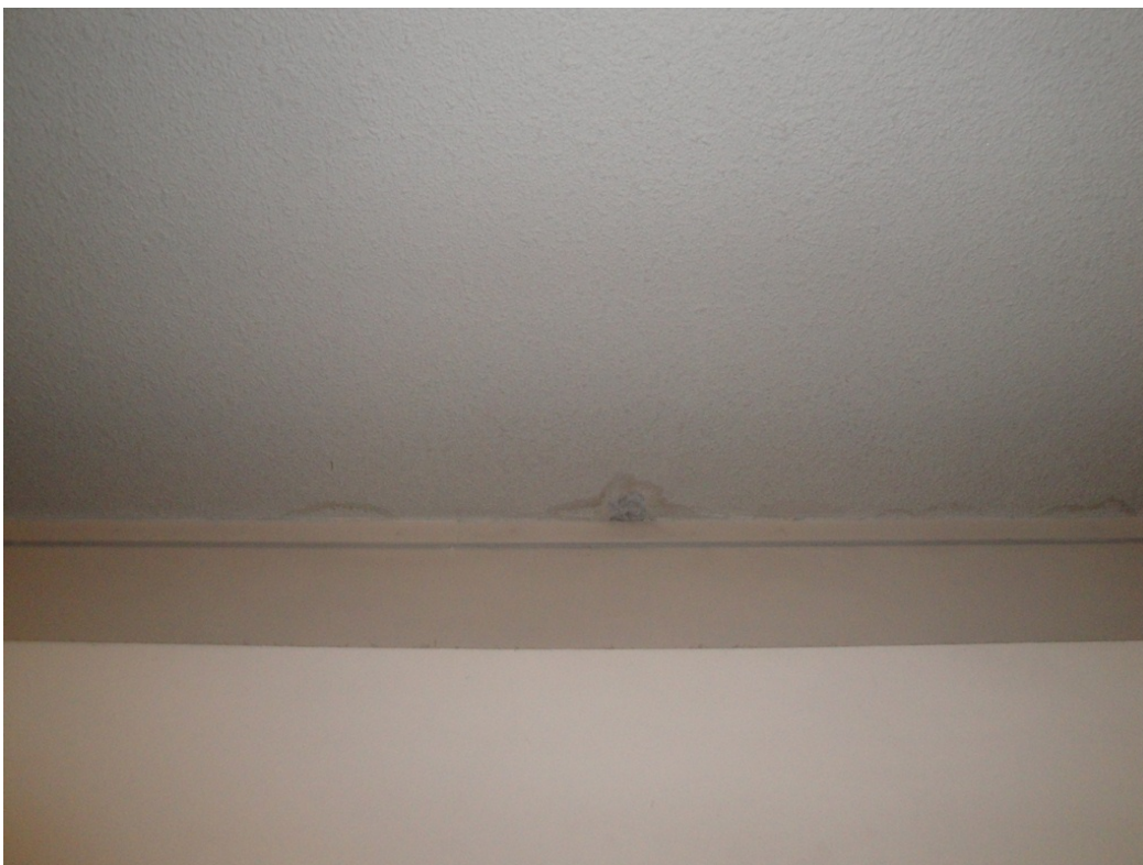
KUVA 20. Huoneiston B16 kosteusvaurio sisäkatossa olohuoneessa ja julkisivun ikkunanauhan kohdalla ulkoseinällä
