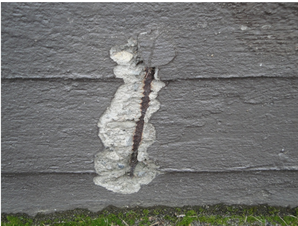
KUVA 4. Raudoituksen korroosiosta aiheutuvia perusmuurin vaurioita
