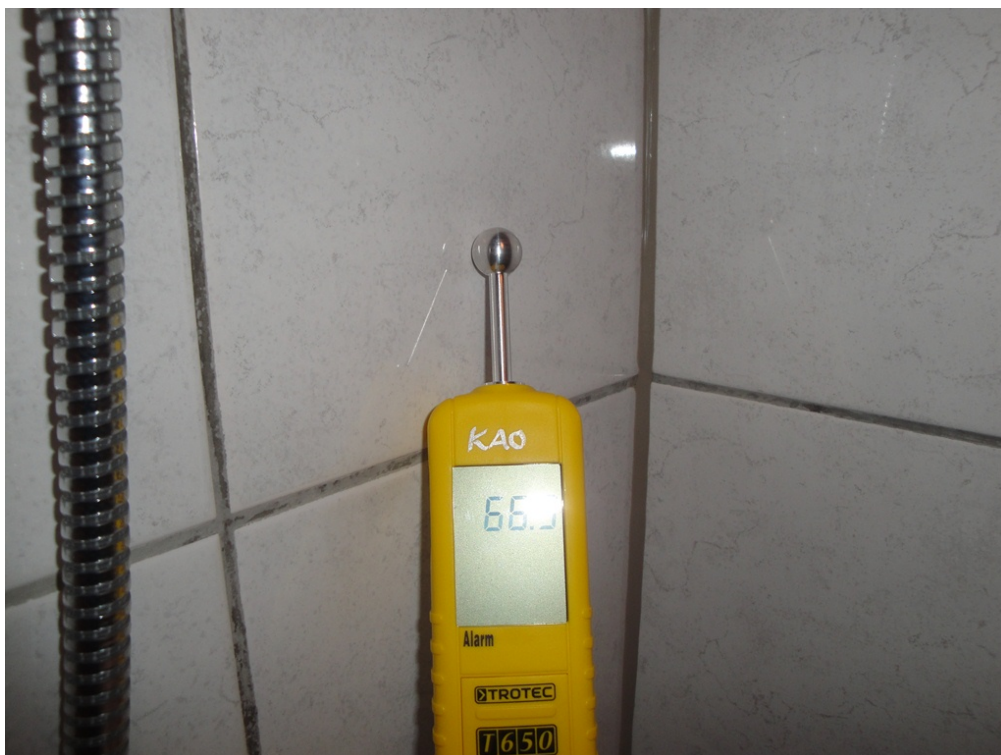
KUVA 24. Taloyhtiön pesuhuoneen seinän kosteusmittaus
