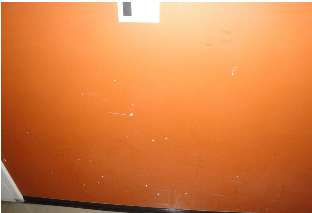
KUVA 27. Porrashuoneen seinän maalipinta
