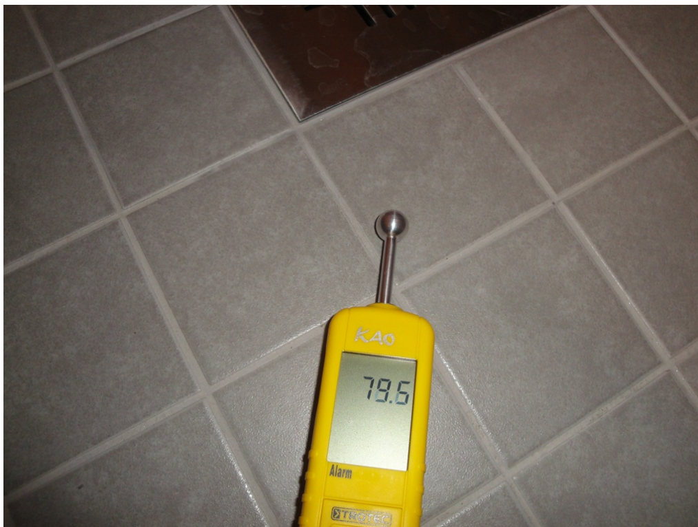
KUVA 23. Taloyhtiön pesuhuoneen lattian kosteusmittaus
