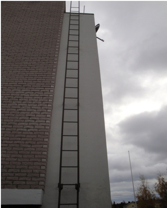
KUVA 19. Talotikkaiden turvalajaan kiinnityskisko puuttu
