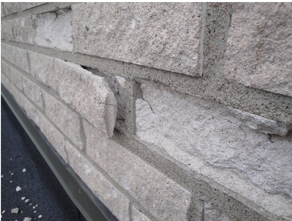
KUVA 12. Tiiliulkoverhouksen pakkasen ja kosteuden aiheuttamaa rapautuma
