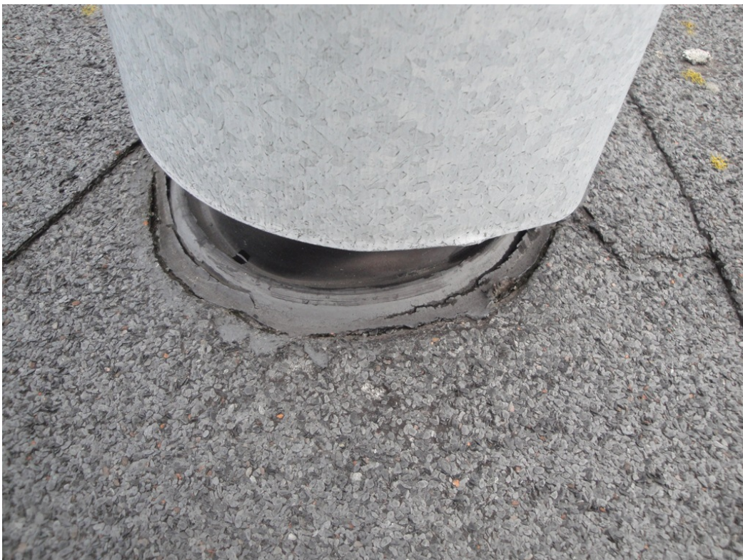
KUVA 10. Kattoläpiviennin halkeillut juuritiivistys
