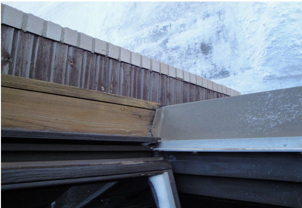
KUVA 16. Ikkunan vesipellin väärä asennustapa/ ulkoverhouksen maalin hilseily
