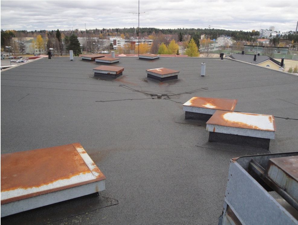
KUVA 7. Vesikatto ja ruosteiset kattoluukut
