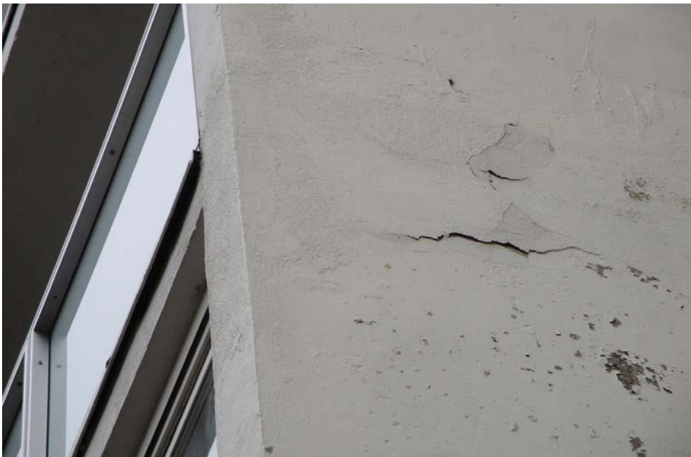
KUVA 15. Parvekelinjoissa betonirakenteiden pintavaurioita
