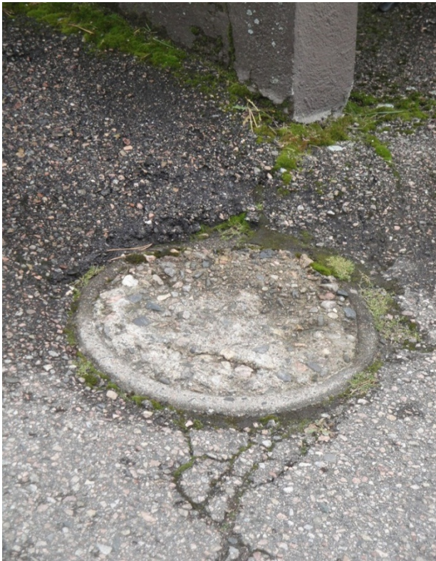
KUVA 5. Kiinteäksi betonoitu kansi salaojan tarkastus/ lietekaivossa
