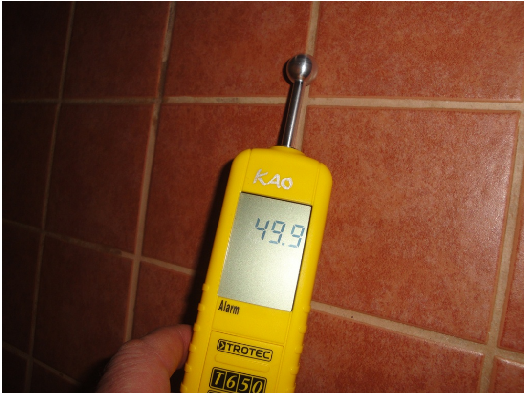
KUVA 25. Asuinhuoneiston pesuhuoneen lattian kosteusmittaus
