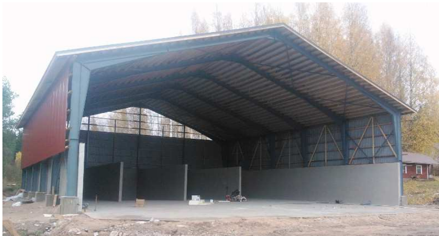
Kuva 2. Esimerkki kantavasta teräsrakenteesta (teräsrunko 22m * 25m)
