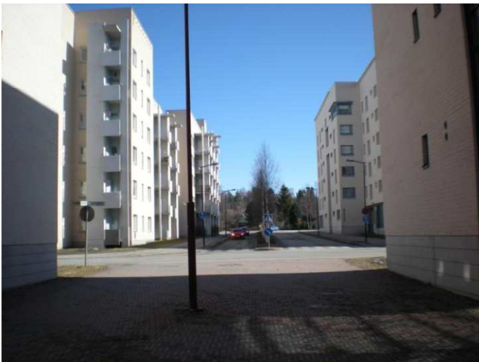
Lähekkäin olevia rakennuksia
