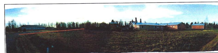
Kuva 5 Kuva Tainiontieltä etelään päin. Kaavamuutosalue kuvassa vasemmalla.
