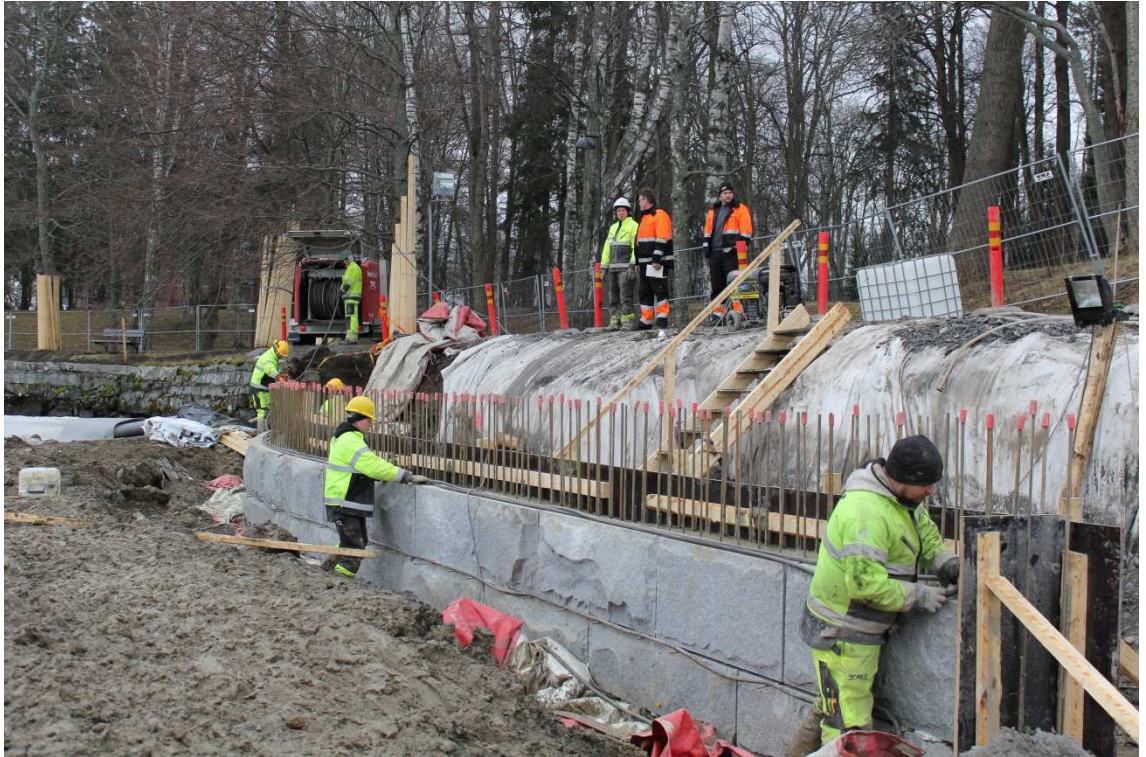
KUVA 20. Kulmatukimuurin tekemistä Tampereen Hatanpäässä.
