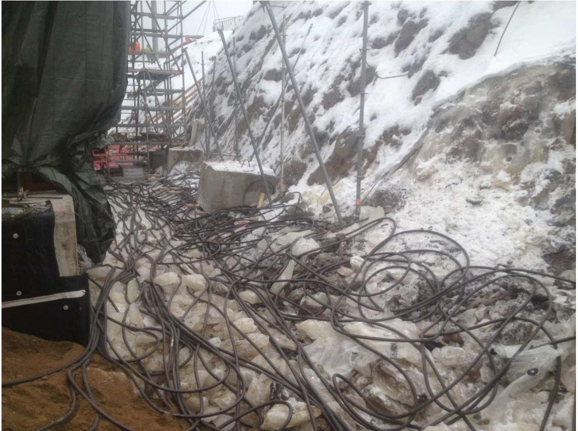
KUVA 12. Glykoliletkut levitettynä sulatettavan alueen päällä.
