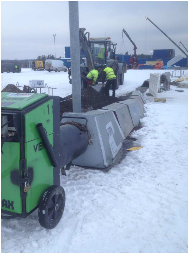
KUVA 17. Kaapelikaivannon sulattamista polttoöljykäyttöisellä roudansulattajalla.
