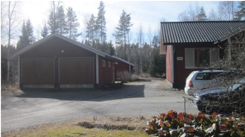
Kuva 4. Autotalli, jonka taustalla näkyy myös hieman puuvajaa, 2014
