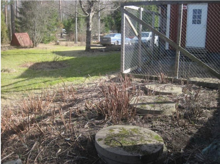
Kuva 9. Saostuskaivojen asema taloon ja kaivoon nähden, 2014
