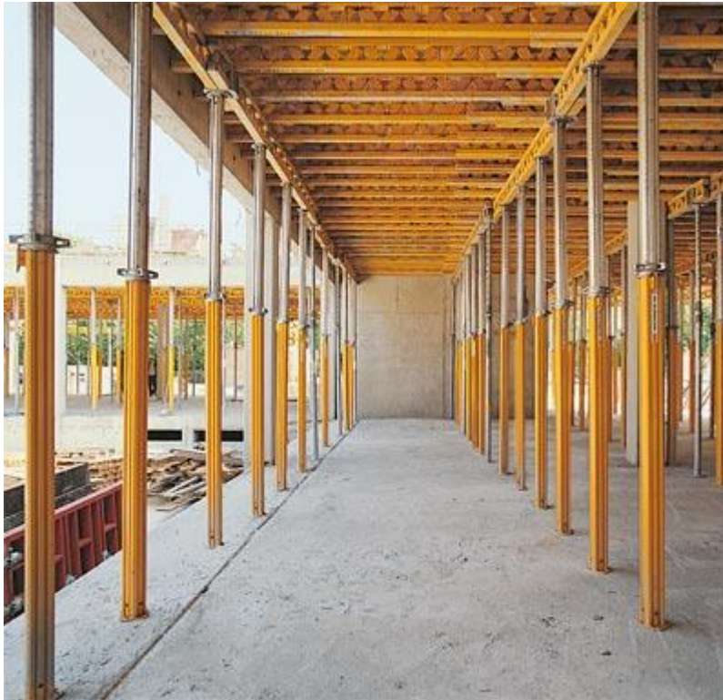
Kuva 10. Multiflex-järjestelmä asennettuna. (PERI Suomi Ltd Oy 2013.)
