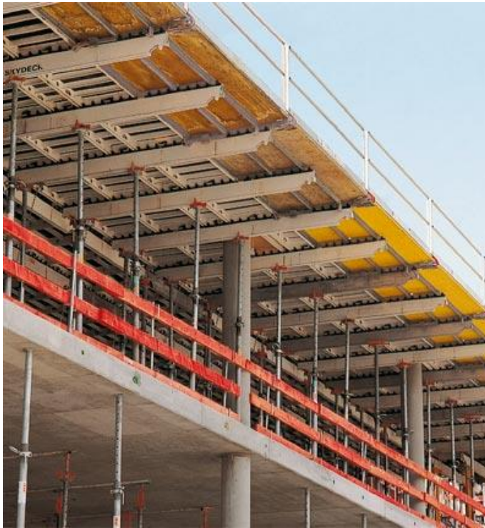
Kuva 13. Skydeck-kasettiholvimuottijärjestelmä asennettuna. (PERI Suomi Ltd Oy 2013.)
