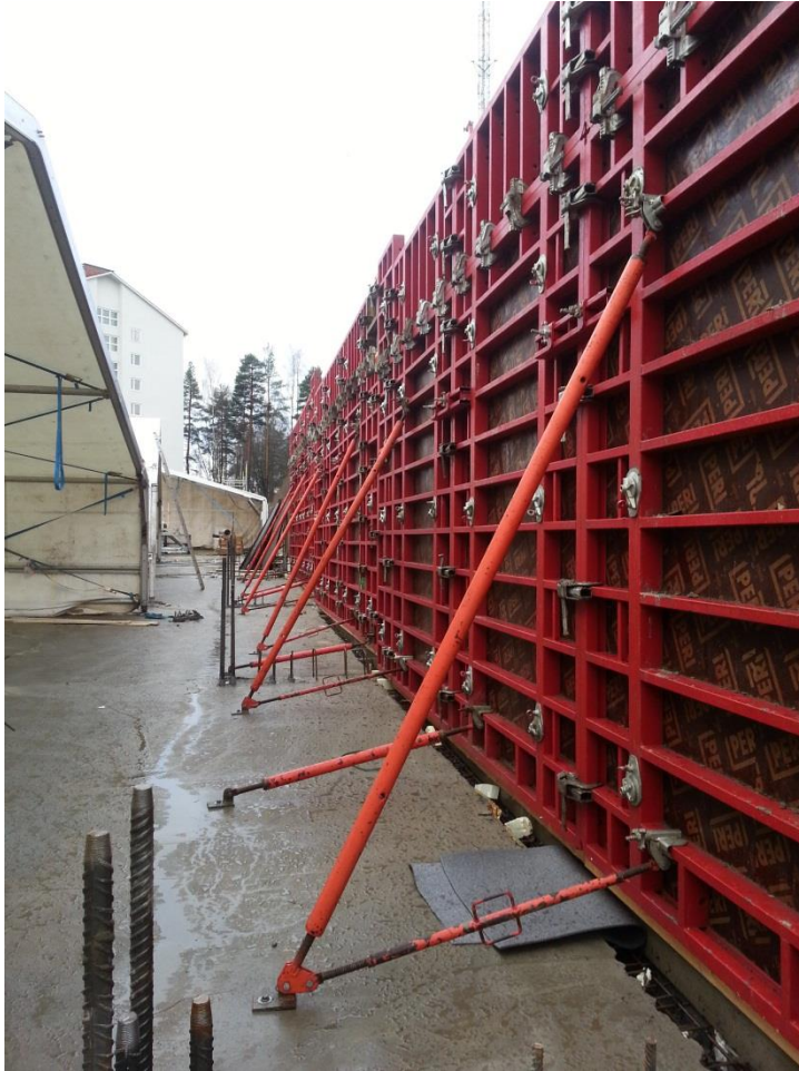
Kuva 17. Maximo-seinäkasettimuotteja paikalleen asennettuna.
