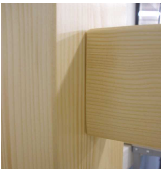
Kuva 11. Kiinnike upotettuna puun sisään.
