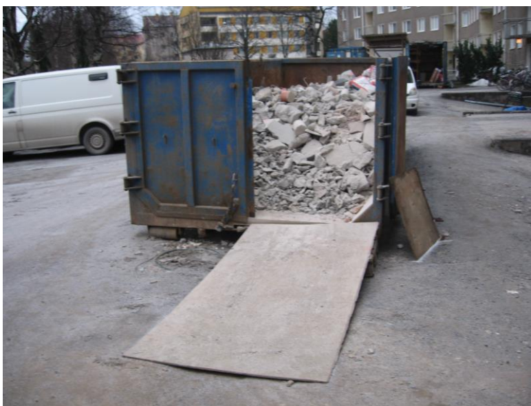
Kuva 3. Kiinanmuurin linjasaneeraustyömaan kivi- ja betonijätelava
