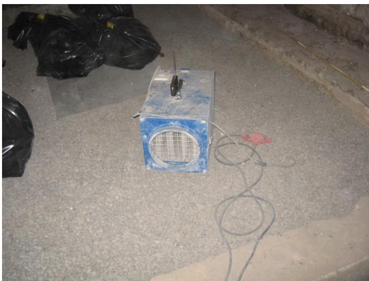
Kuva 2. Kiinanmuurin linjasaneeraustyömaan alipaineistuslaite
