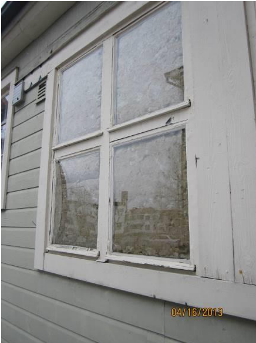
Kuvio 17 Pohjoispuolen ikkuna.
