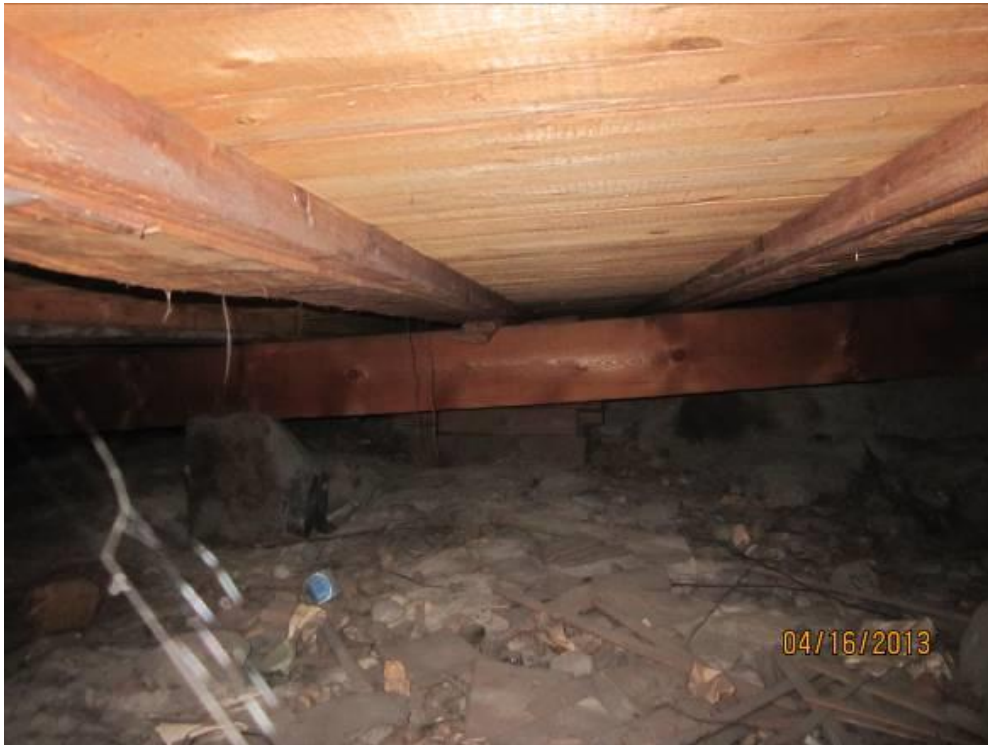
Kuvio 4 Alapohjan tuuletustila eteläpuolelta
