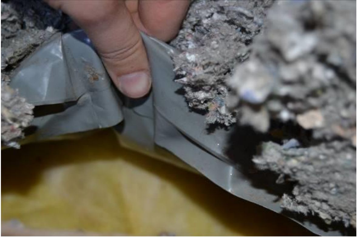
Kuvio 12 Yläpohjan eristeitä
