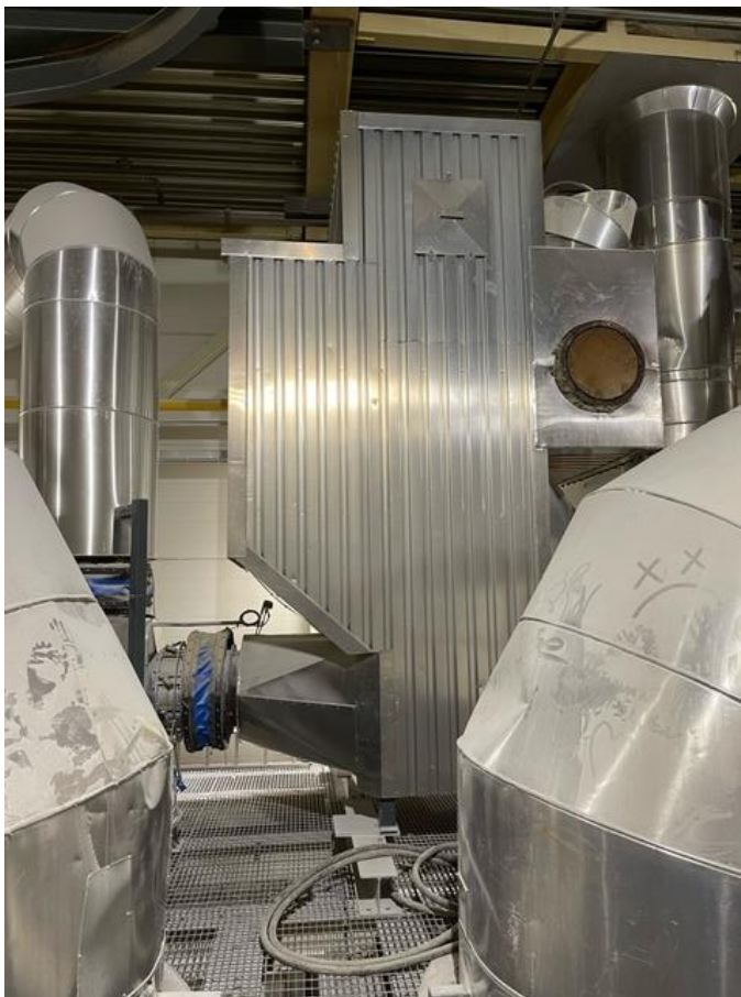
KUVA 5. Ilmakuivaimen lämmönvaihdin.
