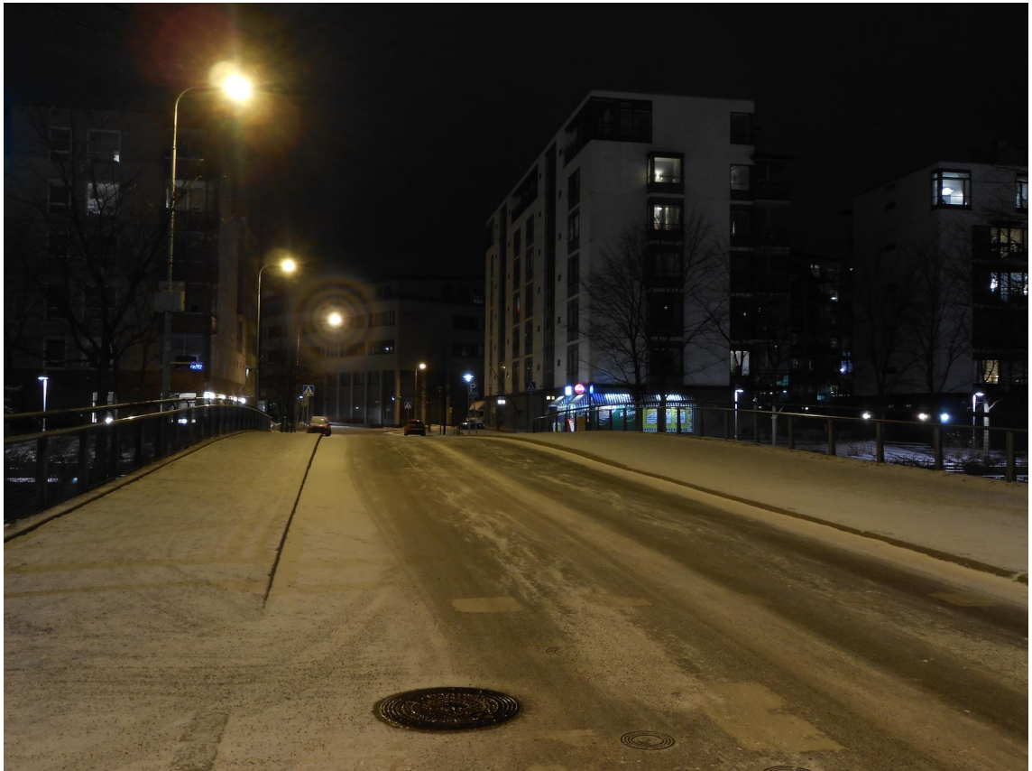
Kuva 2. Jalkakäytävän taakse sijoitettu valaisinpylväs
