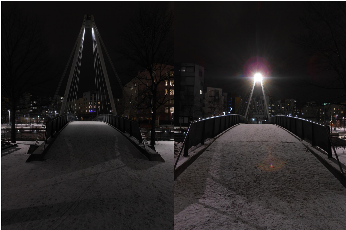
Kuva 6. Vasemmalla valonheittimestä tulee väylälle selvä raja; oikealla valonheittimen valokeilaa voisi rajata ja näin vähentää häikäisyä sekä ohi menevää valoa
