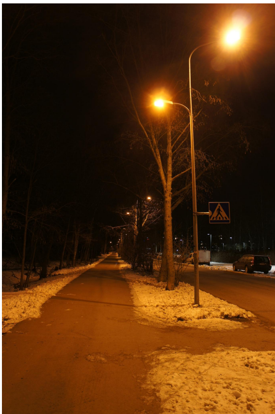
Kuva 4. Ajorata ja jalkakäytävä valaistu pylvällä, joihin on asennettu kaksi valaisinta
