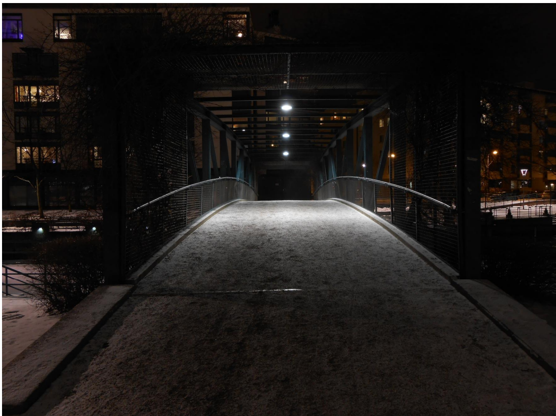
Kuva 7. Valaistuksessa on käytetty hyväksi sillan kattomaista rakennetta
