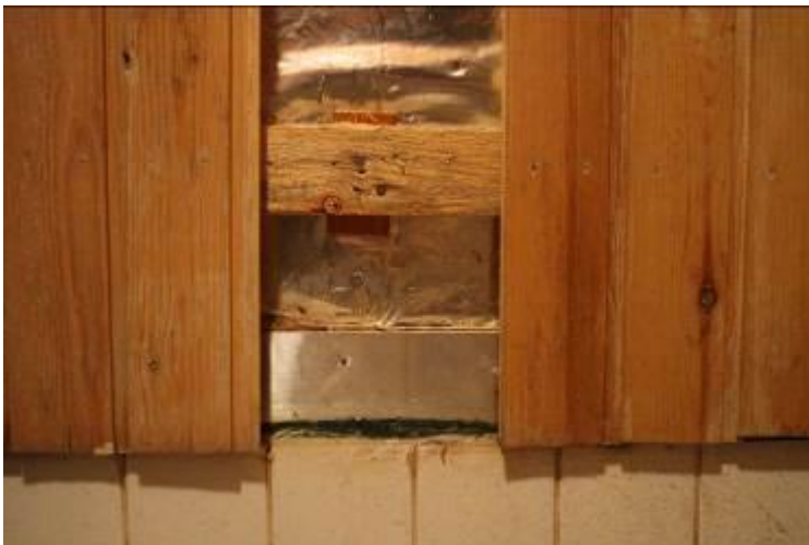
KUVA 13. Pesuhuoneen seinä paneelien takaa
