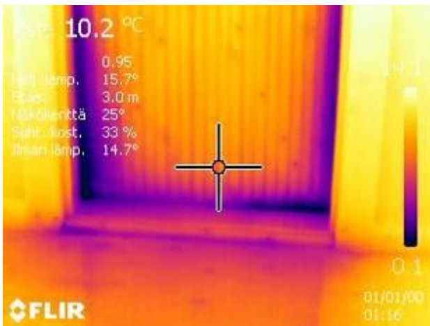
KUVA 21. Kylmänvintin oven lämpökuva
