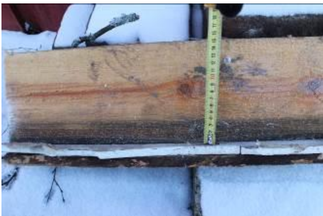
KUVA 8. Kosteuden nousu lattiapalkissa
