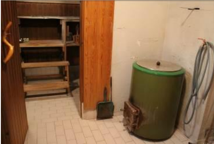
KUVA 14. Pesuhuoneen vesipata ja sauna
