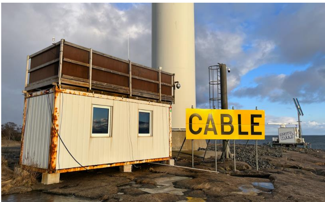
Kuva 6. Kuva Tahkoluodon Kallioholmasta. Vasemmalla havainnointilava ja oikealla tutkajärjestelmä. (Tuomas Ketonen, 2022)
