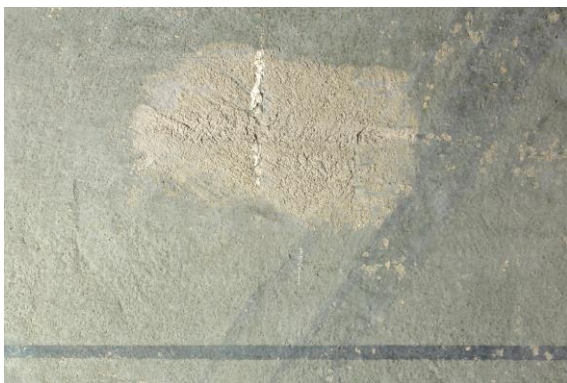
Kuva 40. Sementtipaikkaus koillisseinällä
