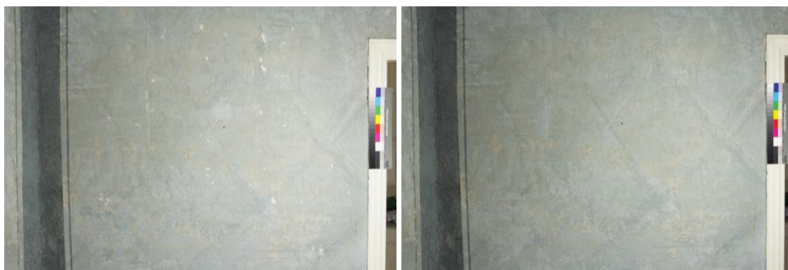
Kuva 41. Naulanreiät paikattuna Modostuc-tasoitteella
