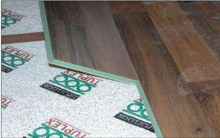
Kuvio 19: Lukkoponttilaminaatin asennus. (Laminaatin asennus 2009).
