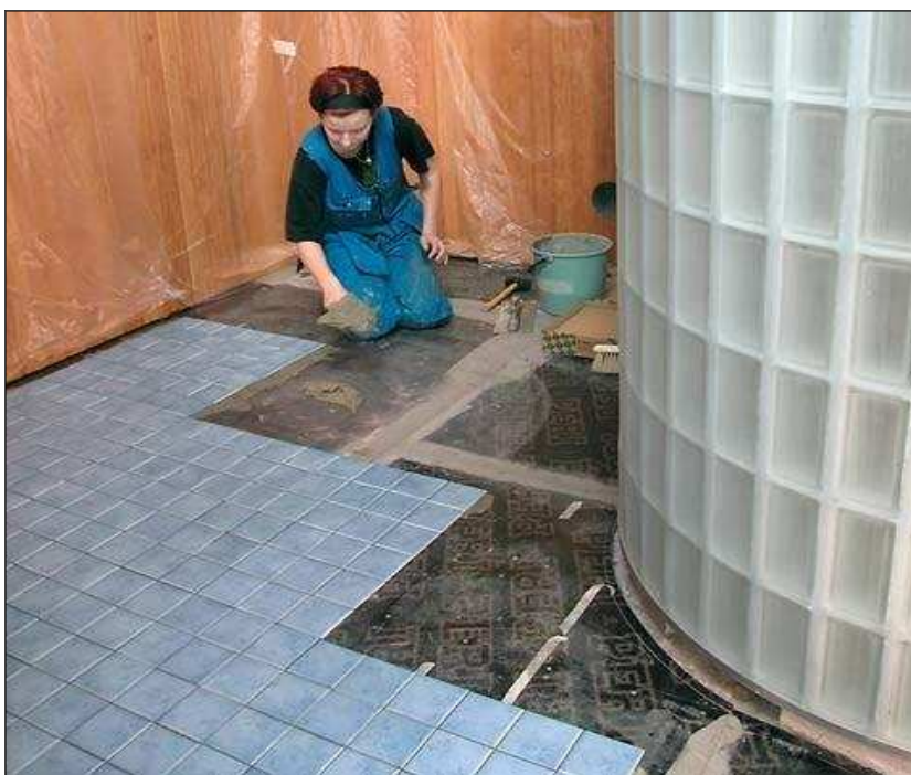
Kuvio 21: Klinkkereiden asennus.(Laatan asennus 2009).
