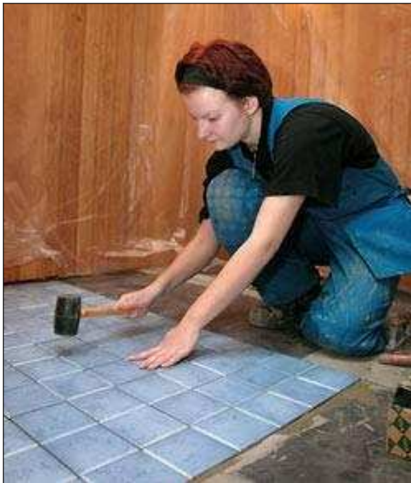
Kuvio 44: Laattojen kiinnitys (Laattojen asennus 2009).
