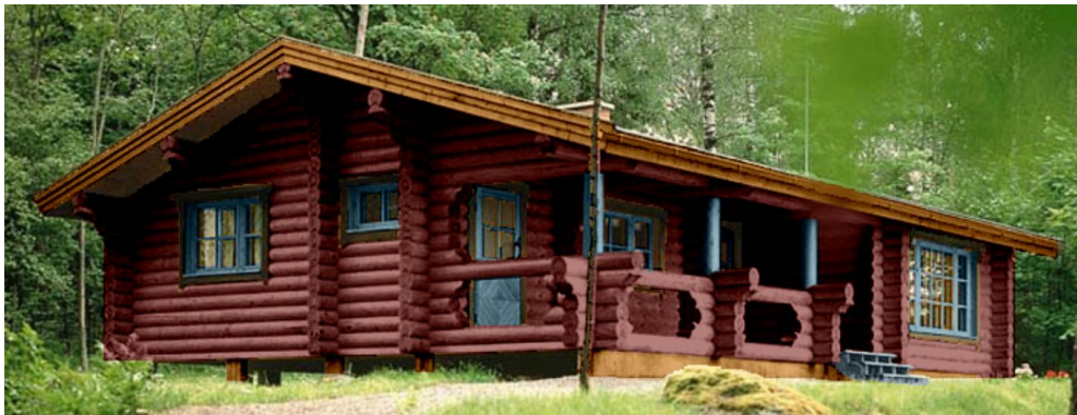
KUVA 7. Esimerkki Internet-sivujen kautta käytettävästä ohjelmasta, jonka avulla voidaan vaihdella värejä eri rakennusosissa vertaillen väriyhdistelmiä. (Tikkurila)
