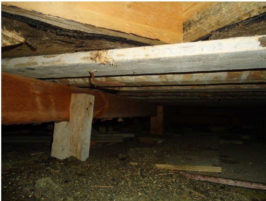
Kuvio 6. Vesikaton puisia alusrakenteita
