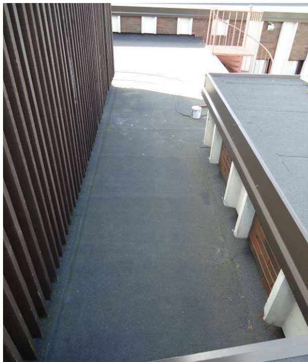
Kuvio 5. Vedenpoiston kannalta hankala kohta katolla. Syvennyksestä on kattokaivolle pitkä matka ja alueelle kerääntyy talvella huomattavasti lunta.
