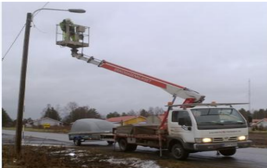
Kuvio 5. Katuvalaisimen ja metallivarren vaihtotyö.
