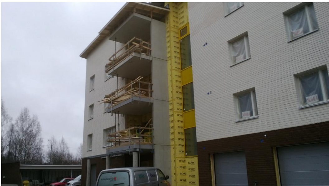
Kuvio 6. Rakennustyömaa As Oy Seinäjoen Helena.
