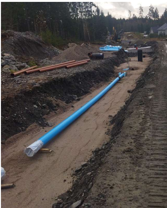
Kuva 5. Putken suojaus (Antti Löyttynen 2021).
