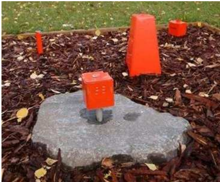
Kuva 1. Erilaisia putkipyykkejä [Rummukainen 2013]
