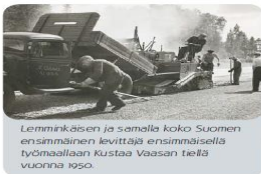
Kuva 4. Asfaltin levitys vuonna 1950 [8].
