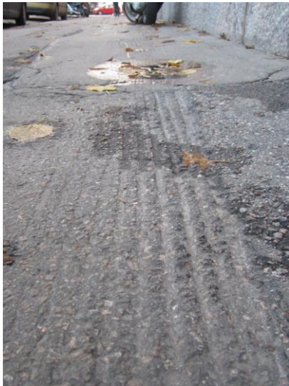
Kuva 14. Urat asfaltissa. Syynä voi olla esimerkiksi lumiauran hampaiden jättämät jäljet.
