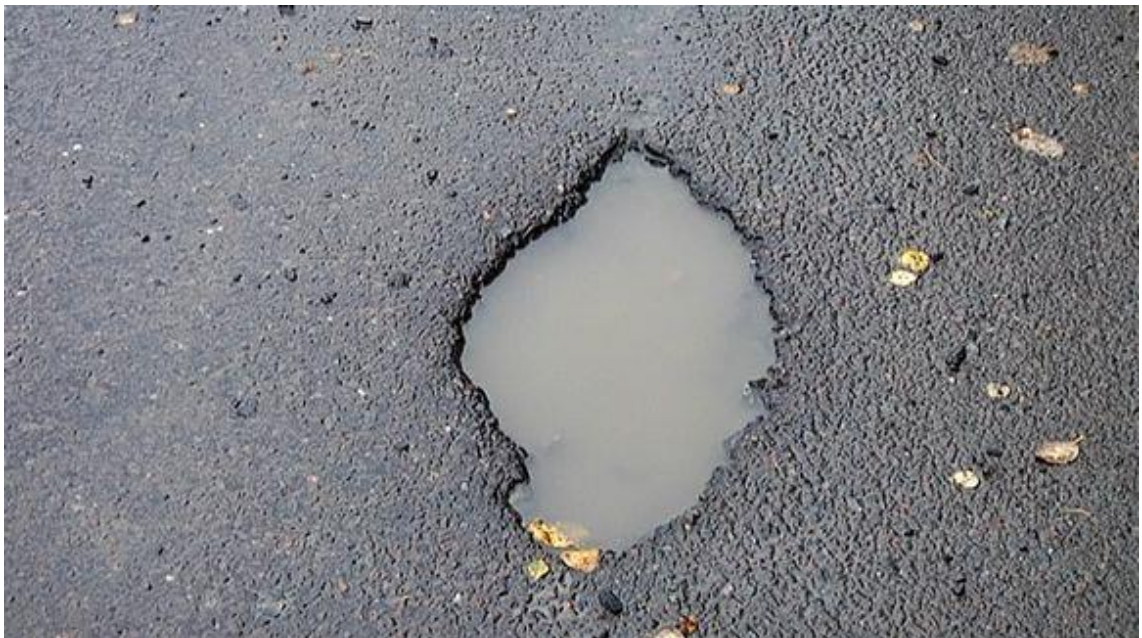
Kuva 18. Purkautuminen ilmenee asfaltin reikiintymisenä. Jatkuva jäätymis-sulamisvaihe heikentää bitumin ja kiviaineksen välistä tarttuvuutta, mistä purkautuminen aiheutuu.
