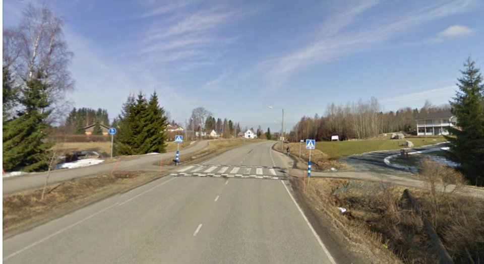
Kuva 6. Läyliäistenraitin kevyenliikenteenväylä ja korotettu suojatie
