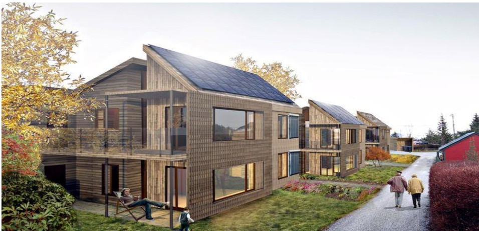
Figur 6. Bild av passivhus med solfångare på taket.
