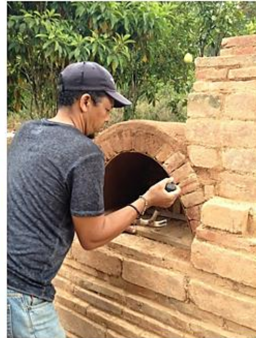
Kuva 16. Uunin suunnittelua. Kuva 17. Polttokammion mallintamista. Kuva 18. Polttokammion kaaren viimeistelyä.
