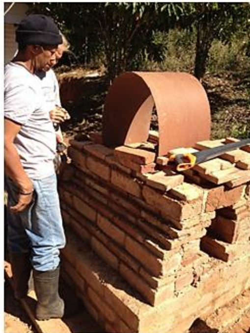
Kuva 16. Uunin suunnittelua. Kuva 17. Polttokammion mallintamista. Kuva 18. Polttokammion kaaren viimeistelyä.
