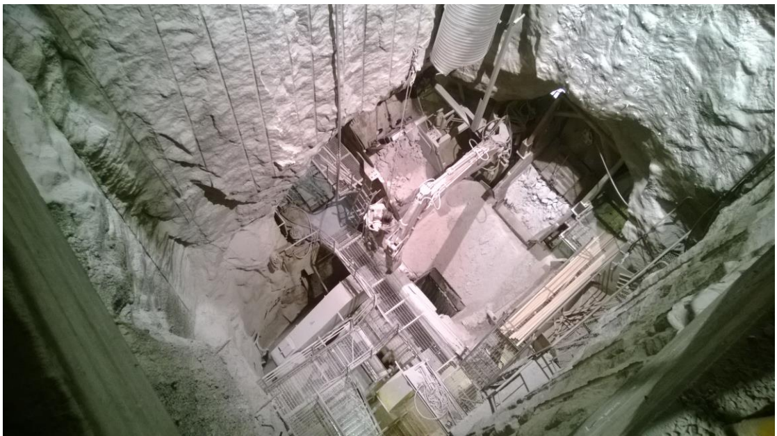
Kuva 6, Murskaimen laitteisto valvontakerroksesta nähtynä
