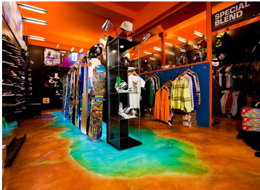
KUVA 27. Happovärjätty betonilattia (Designbetoni s.a.)
