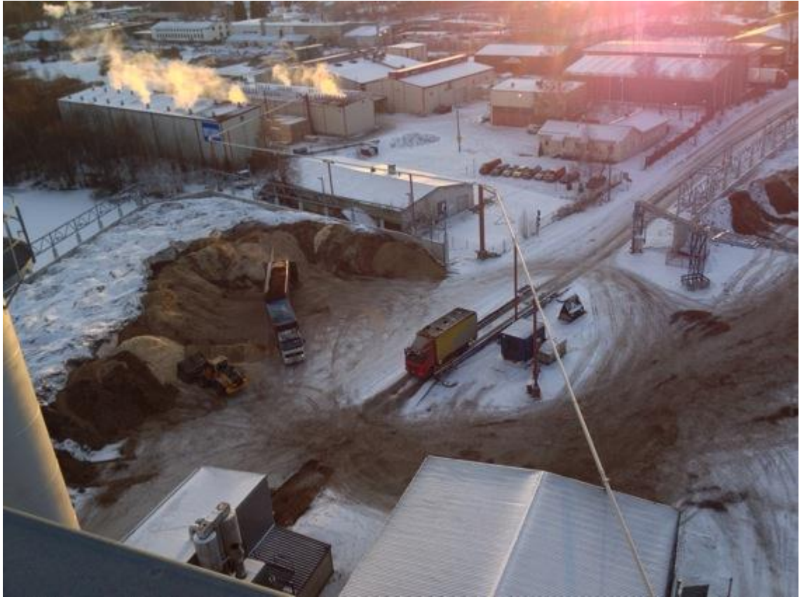
Kuva 11. Polttoaineen vastaanotto Pursialan voimalaitoksella (ESE)
