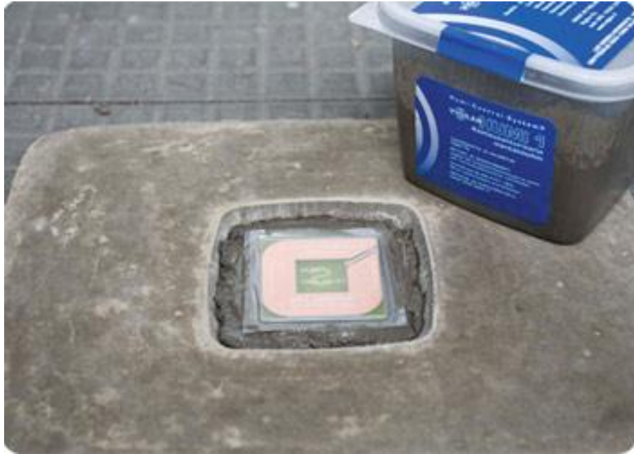
Kuva 18. Humi 1-kosteusanturi asennusvaiheessa (Vigilan Oy 2014).
