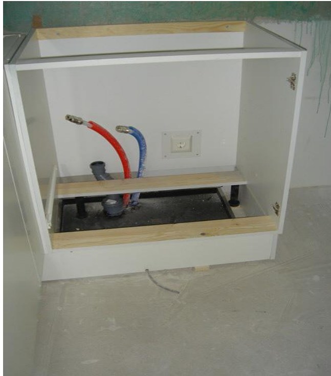
Kuva 12. LeakFence-vuotoallas asennusvaiheessa (Q Keittiöt, henkilökohtainen tiedonanto 2/2014).
