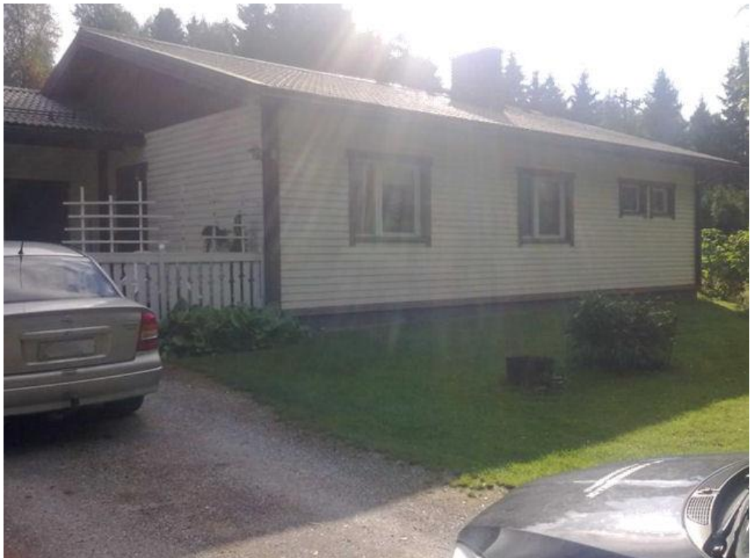
Kuva 5. Kohde 2 ulkopuolelta (If Vahinkovakuutusyhtiö Oy, henkilökohtainen tiedonanto 12/2013).
