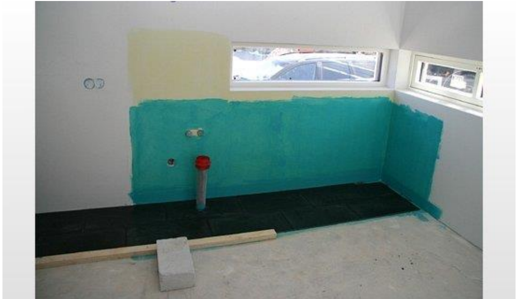
Kuva 16. Keittiön rakenteiden suojaus nestemäisellä vedeneristeellä (Rakentaja.fi 2008).
