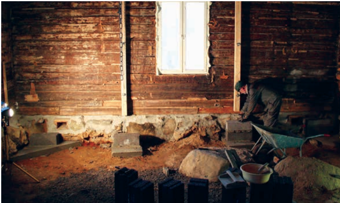
Kuva 13: Lattianiskojen kannatinpilareita muurataan
