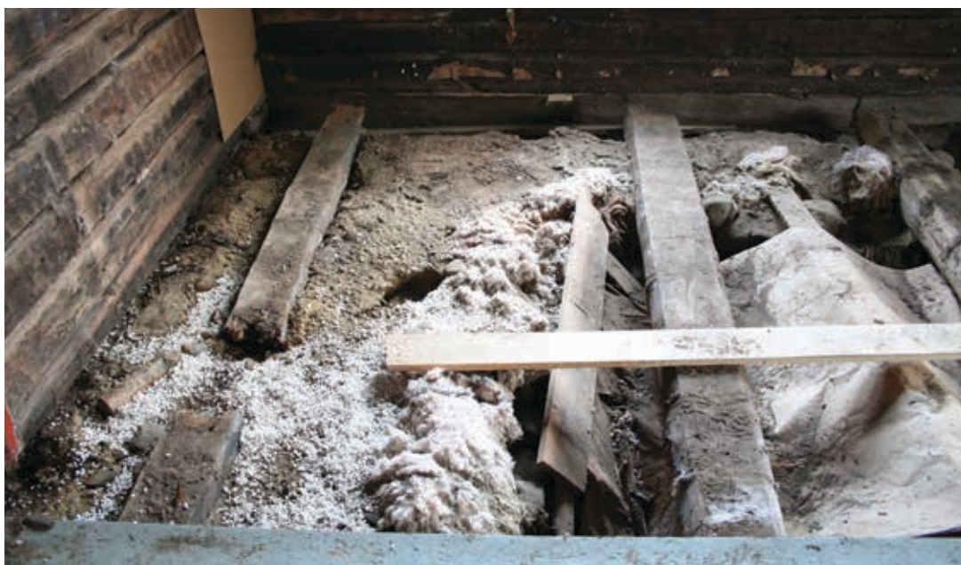
Kuva 10: Lattialankkujen alta paljastuu multipenkki, jonne on täytteeksi sullottu vanhoja matonkuteita maatäytön päälle. Myös jyräjät ovat kaivelleet kolojaan täytteeseen ja levittäneet sitä ympäriinsä. Maakosketuksessa olleet lattianiskat ovat osin lahonneita.
