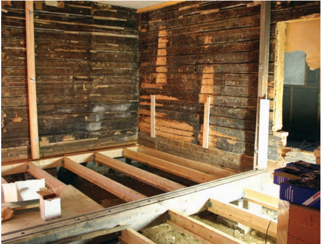
Kuva 15: Lattiapalkit paikoillaan. Palkkien kylkiin on kiinnitetty rimat, joiden päälle rossipohjan pohjalaudoitus laitetaan. Seinään pystyyn lyötyjen merkkilautojen alareuna merkkää lattian vanhojen kannatinhirsien paikkoja.
