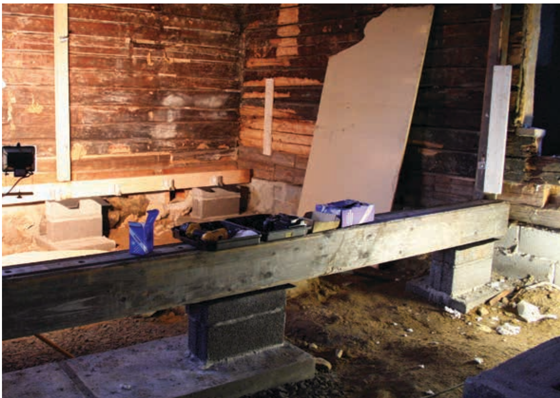
Kuva 14: Lattianiska asennettuna paikoilleen. Päätyseinällä näkyy lankku, johon on kiinnitetty palkkikengät lattiapalkkeja varten.
