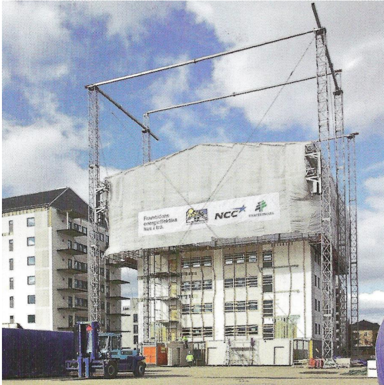
Kuvio 15. Gibson Tower sääsuojarakentamista. (Tolppanen ym. 2013, 172.)
