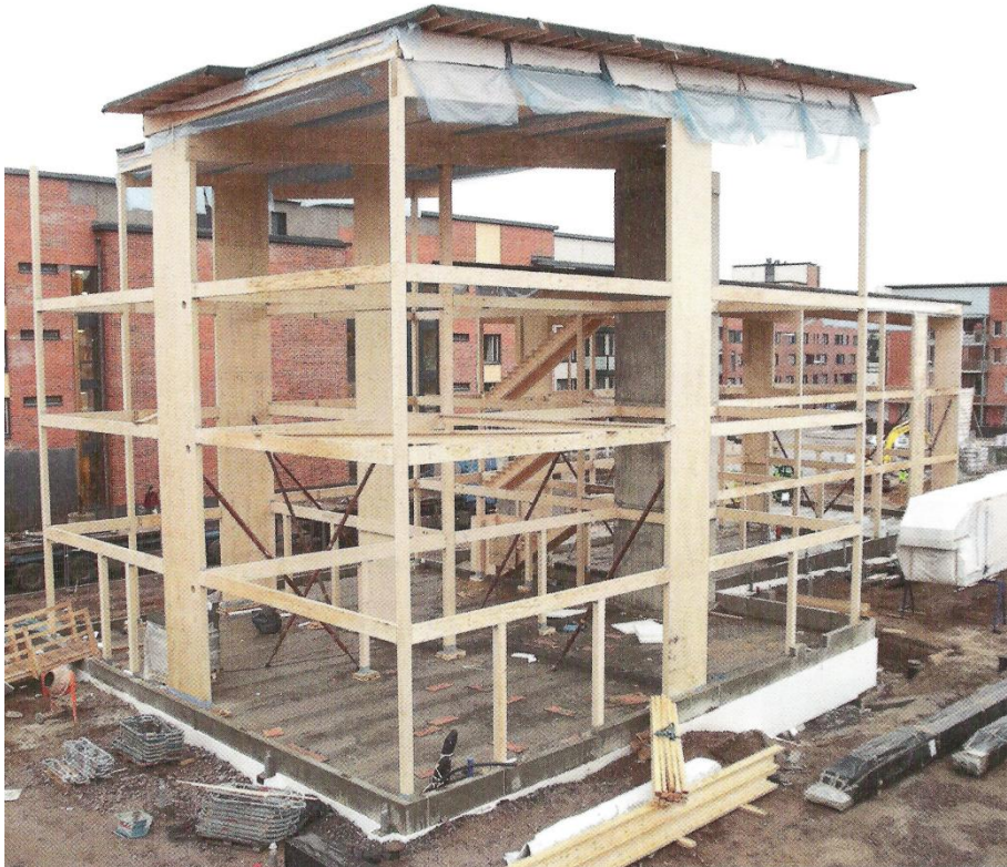
Kuvio 12. Puukerrostalon rungon pystytysvaihe. (Tolppanen ym. 2013, 47.)
