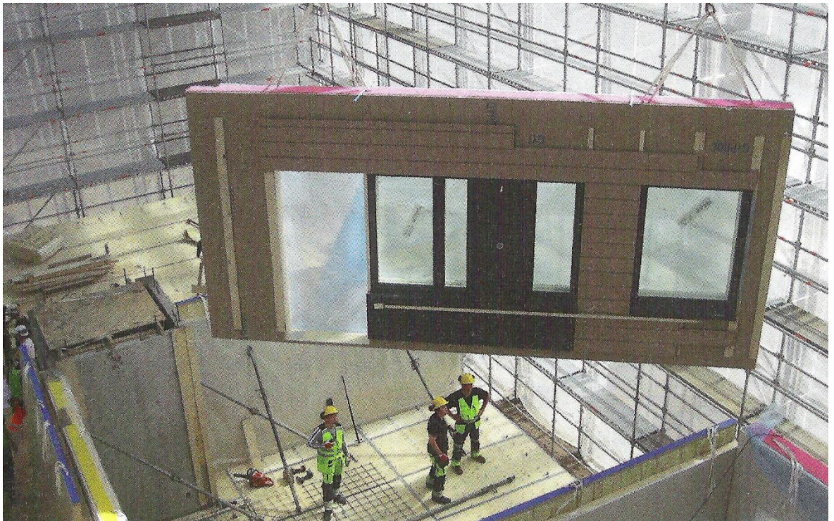
Kuvio 10. Suurelementti asennusvaiheessa. (Tolppanen ym. 2013, 42.)
