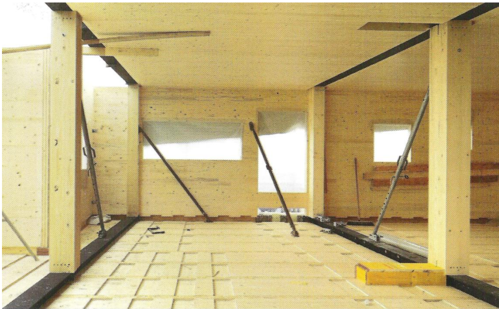
Kuvio 13. CLT-elementeistä löytyy valmiit aukotukset. (Tolppanen ym. 2013, 44.)
