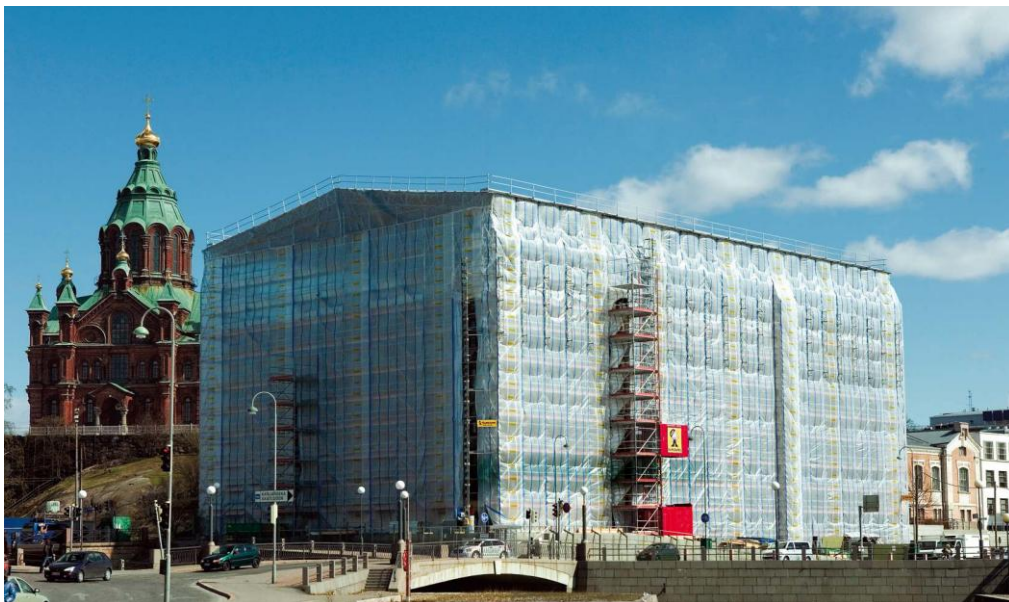
Kuvio 18. Enson talon sääsuojaus Plettac-järjestelmällä. (Ramirent, 2014.)
