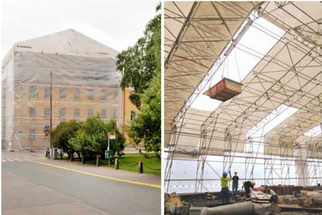
Kuvio 16. Materiaalinoston tapahtuminen KH-suojan sisällä. (Telinekataja, 2014.)
