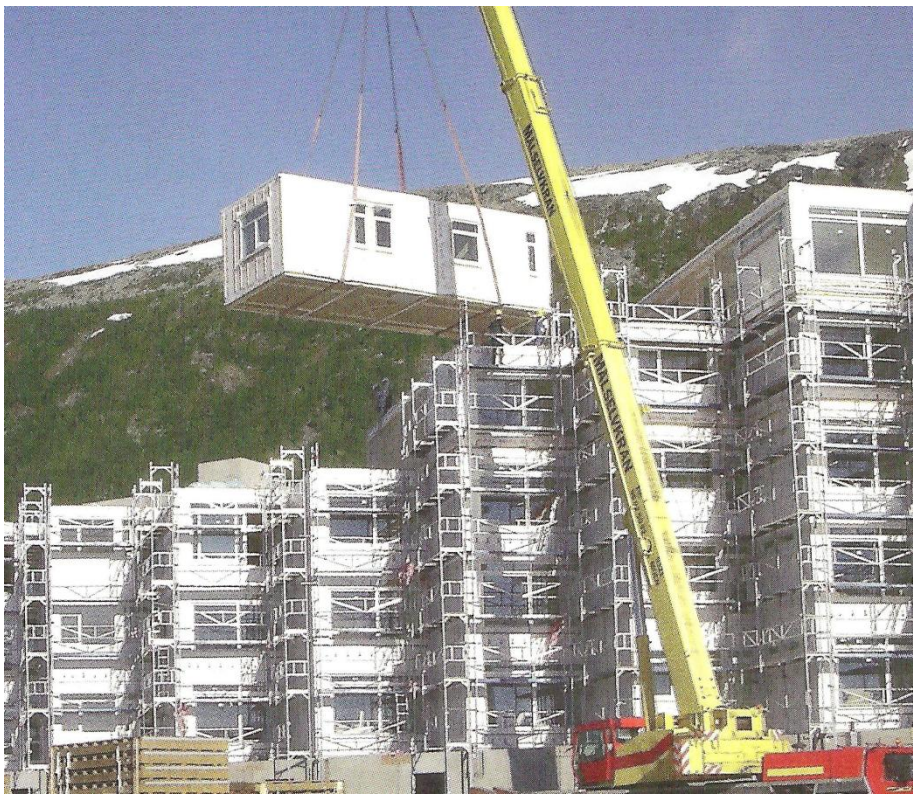
Kuvio 11. Tila-elementtitekniikan käyttöä rakennustyömaalla. (Tolppanen ym. 2013, 49.)
