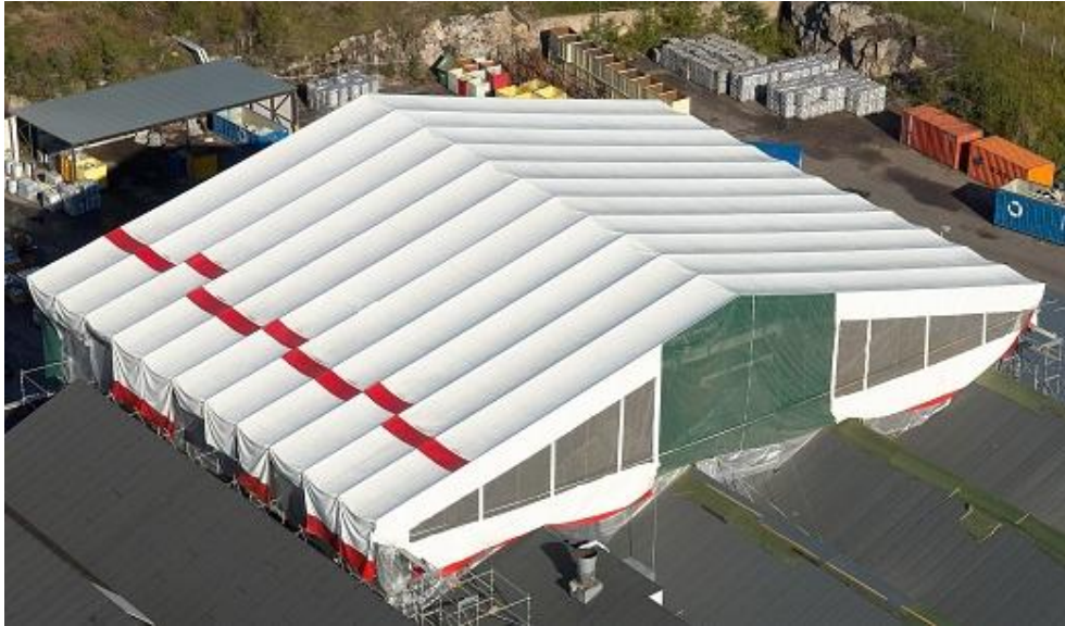
Kuvio 17. Laajan alueen suojaaminen LGS-sääsuojalla. (Ramirent, 2014.)
