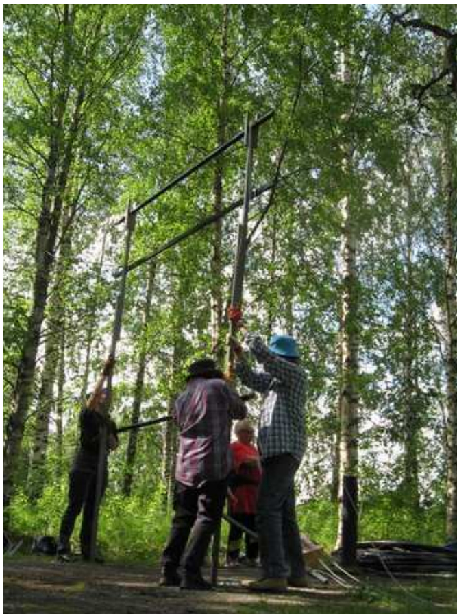
KUVA 3. Riitta-Liisa Komulainen, Taistojen taival -ympäristöteoksen rakentaminen Koljonvirralla heinäkuussa 2008.
