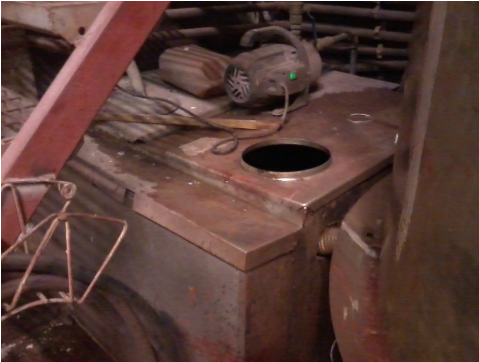
Kuva 2: Vesisäiliönä toimiva maidonjäähdytin
