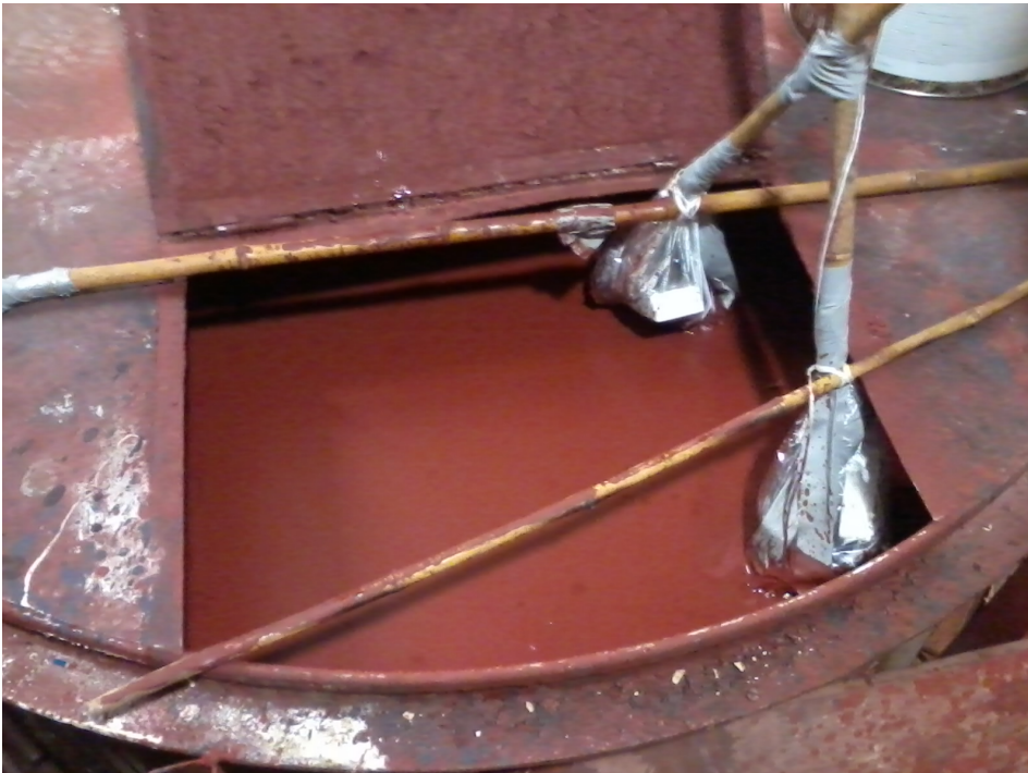
Kuva 5: Maalin sisälämpötilan mittaus
