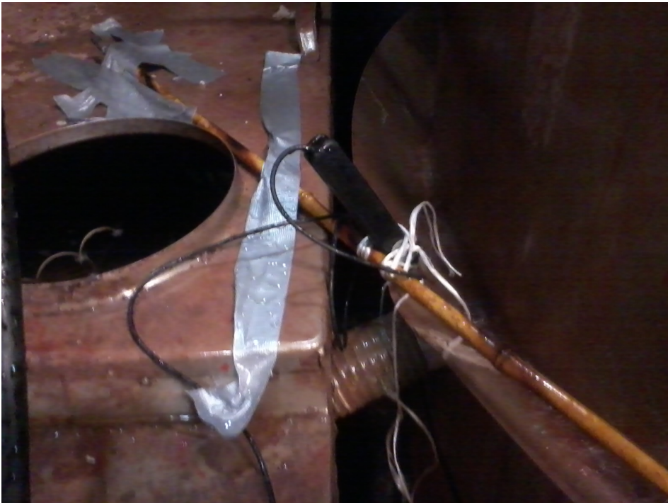
Kuva 7: Jäähdytysveden lämpötilamittaus, alaosa
