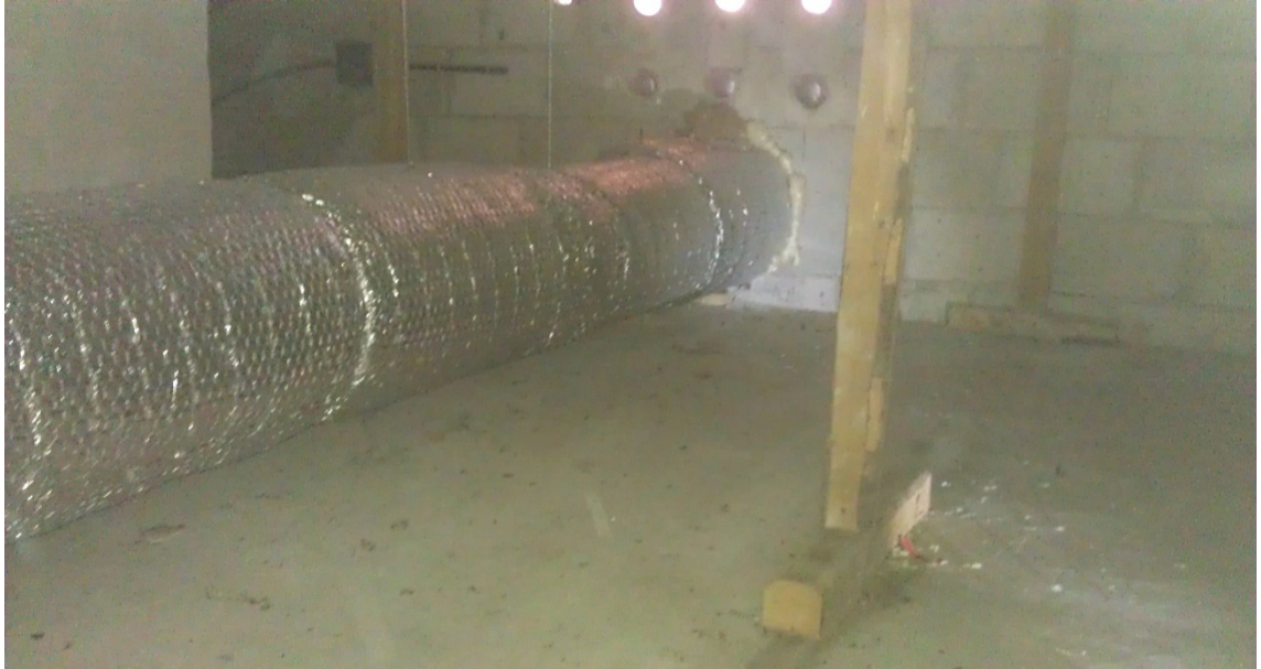
Kuva 4. Vanhan rakennuksen palopermanto, Kuusiston koulu.
