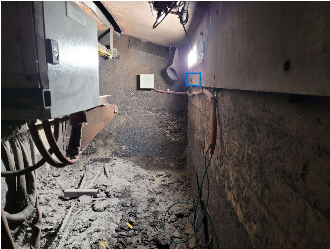
KUVA 18. Tunnelin länsipää. Sinisen neliön paikalla oli Access Point kotelo
