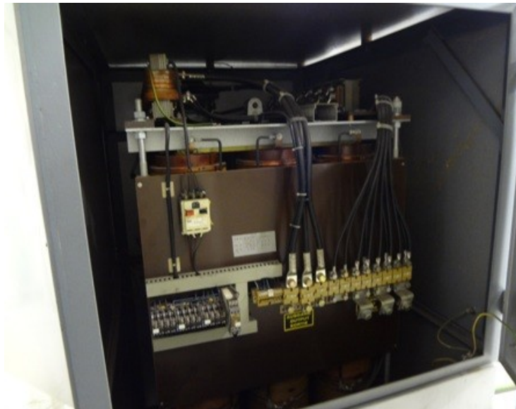
Kuva 1. Säättömuuntaja REO DRTMO 380V/0-600 V, syöttö-, lähtö- ja ohjausliitännät (kuva käyttöön otettavasta muuntajasta).
