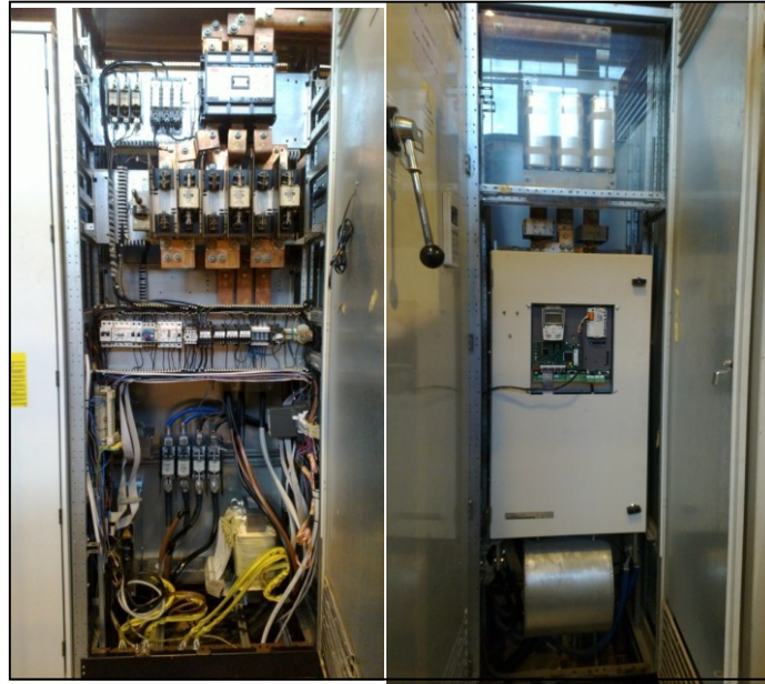
Kuva 3. DC-käytön, DCS602-0900 molemmat kentät (kuva käyttöönotettavasta laitteesta).
