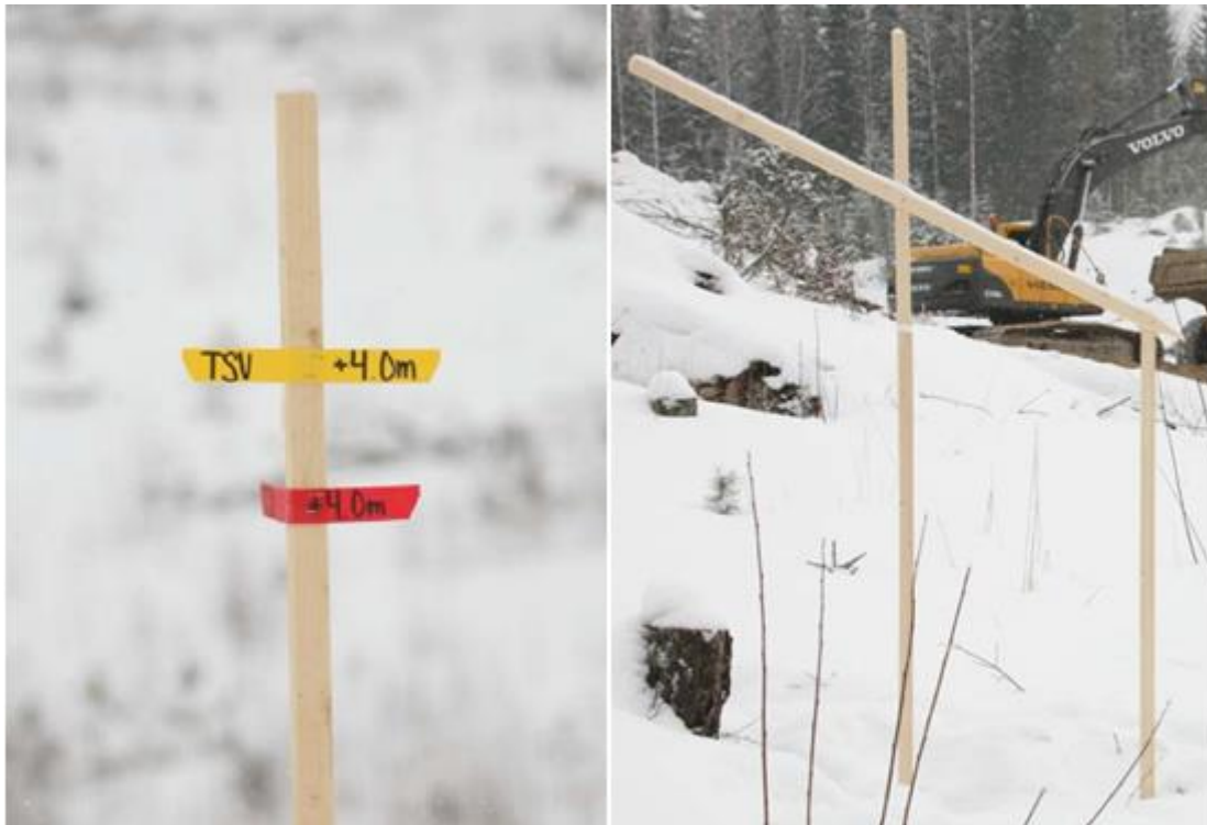
KUVA 2. Vasemmalla mittakeppi, jossa sihtilappu merkattuna tasausviivan korkeoon. Oikealla luiskamalli (Nurminen 2012)
