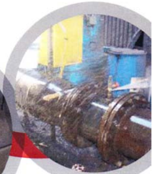
Vuotavien putkien tiivistys
