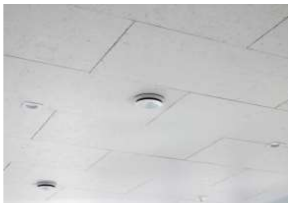
Kuva 14. Maalattu levykatto. (Kuva: Heidi Hyväri.)
