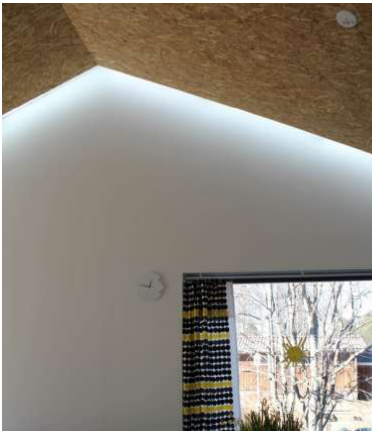
Kuva 8. OSB-levyä katossa (Kuva: Heidi Hyväri).
