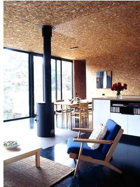
Kuva 26. OSB:levyä seinässä ja katoissa (Kuva: Media Tumblr).
