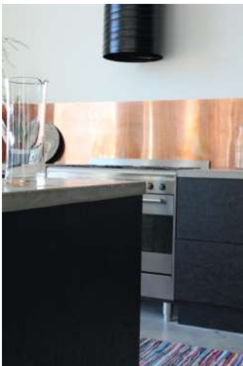
Kuva 13. OSB-levyä keittiökalusteissa. (Kuva: Heidi Hyväri.)
